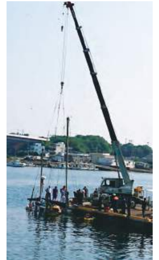
クレーン車による引き揚げ作業
