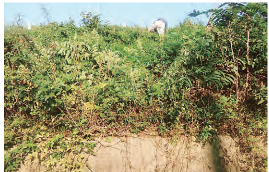
▲清掃作業はこんな高いところでも。危険を伴います
