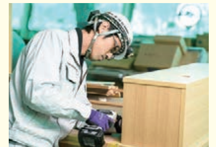
操舵室の内装工事
