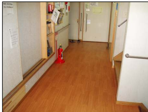
2階 廊下(床板、クッションフロアの張替え)
