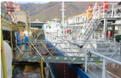
滑り止め加工をした棧橋
