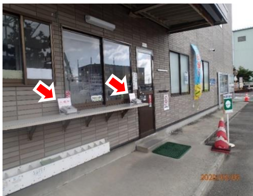
警備員の常駐とICカードを利用した 入出門管理の事例
