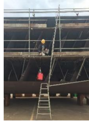
ベルブロック、荷揚ロープ設置の例
