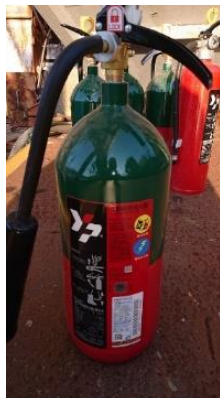
機器類の消火も可能な CO2 消火器と消火器運搬籠の作成例
