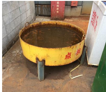
ガスホース点検用水槽
