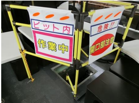
開口部転落防止策の設置例
