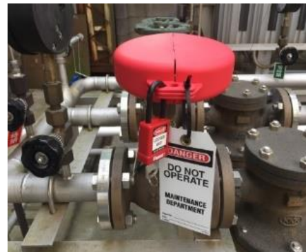
本船内のロックアウト・タグアウト例
