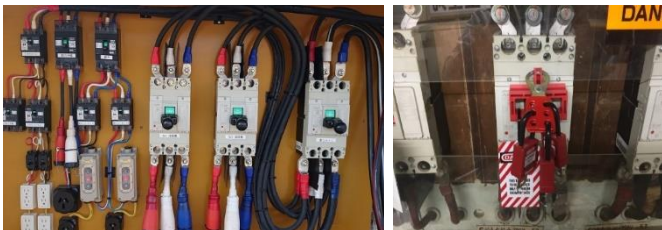
漏電遮断とロックアウト・タグアウトの例
