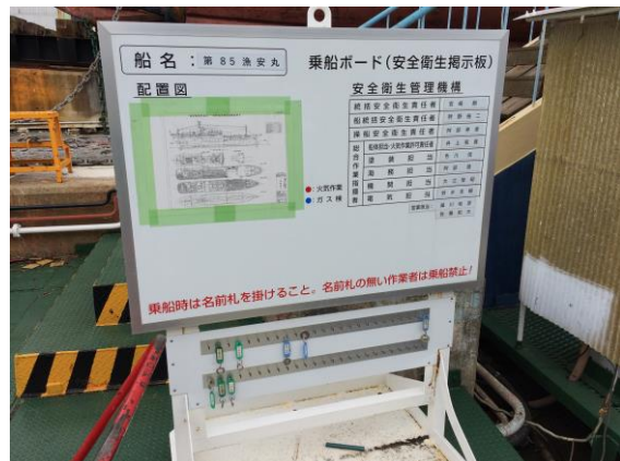
混在作業区画の明示、作業許可書の掲示例
