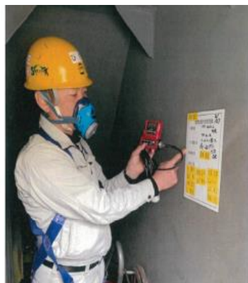
ガス濃度測定と測定結果の掲示例
