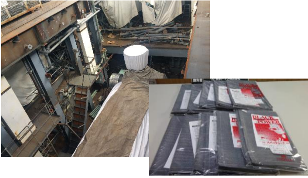
火気作業の養生と養生用マグネット付スパッタシート
