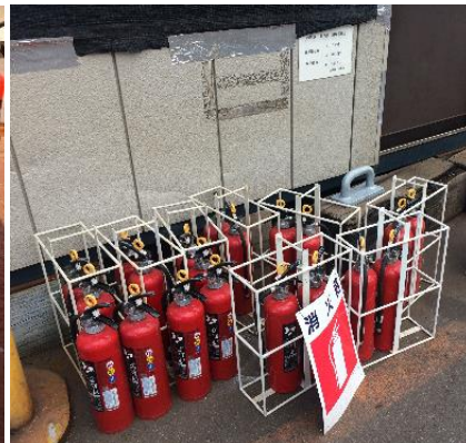
機器類の消火も可能な CO2 消火器と消火器運搬籠の作成例
