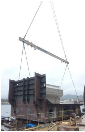
索具が荷に触れないための吊天秤使用例
