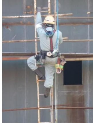
ベルブロック、荷揚ロープ設置の例
