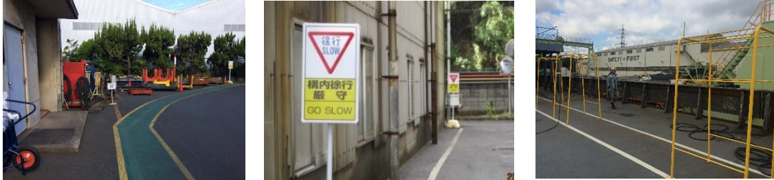
歩行者専用道路、交通標識、安全通路用架台の設置例
