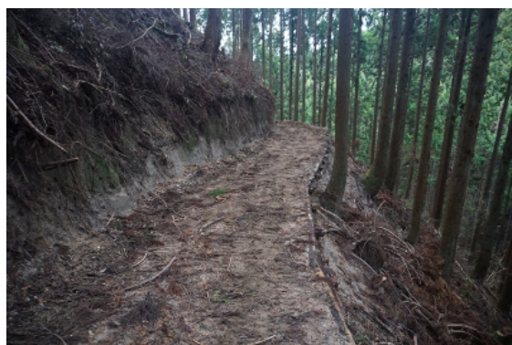
写真4 急斜面でも低い切土高で作業道を開設
