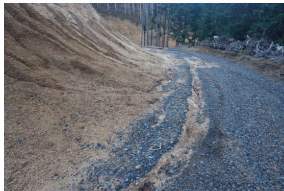
写真9 フロンバッグで修復した路肩が再崩壊 写真10 切土のり面に走るガリーと路面侵食
