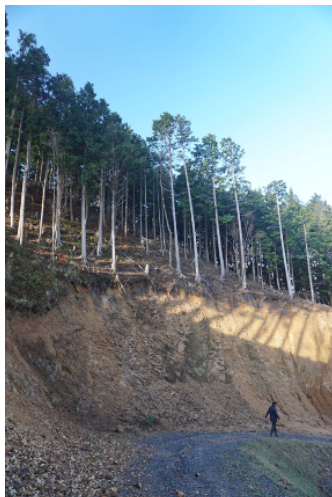
写真7 高い切土法面
