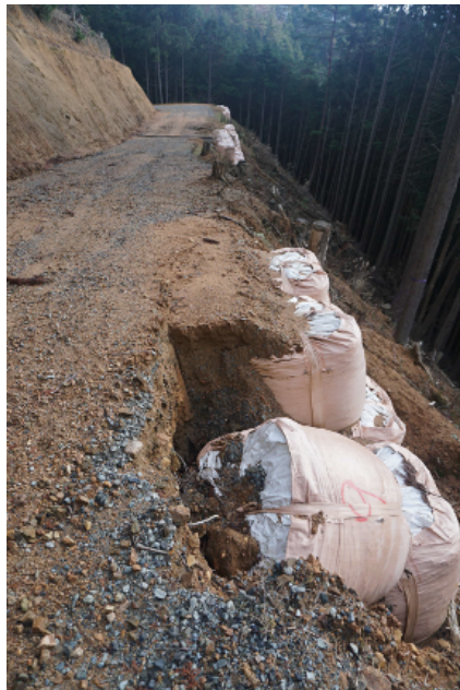
写真9 フロンバッグで修復した路肩が再崩壊 写真10 切土のり面に走るガリーと路面侵食
