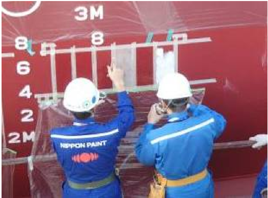
図 3 1 実証予備試験用塗料の刷毛塗り塗装
