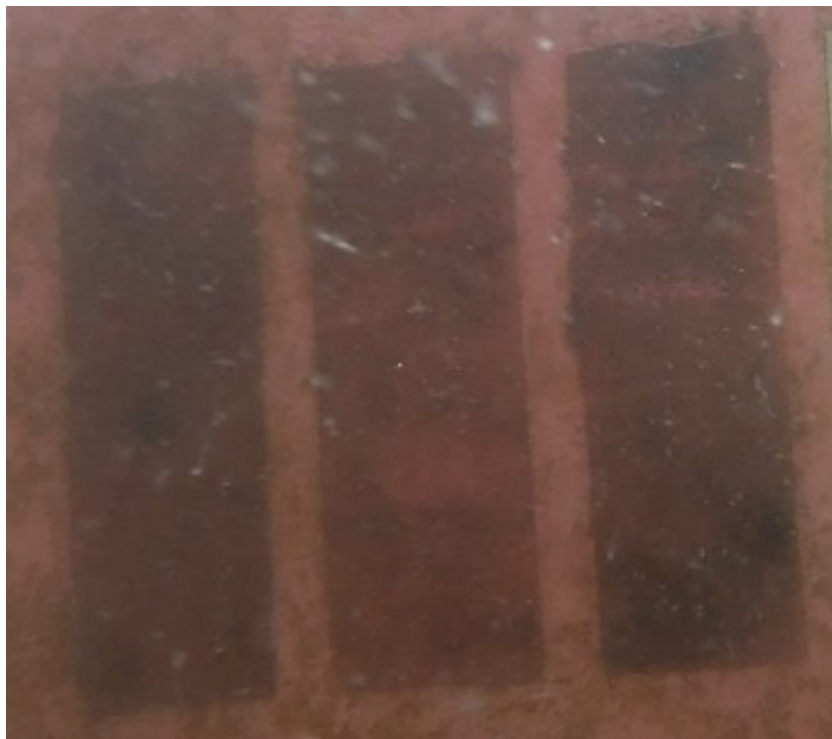
図49 水中カメラによる観察（2ヶ月後・上部塗装箇所 No. 1-3）
