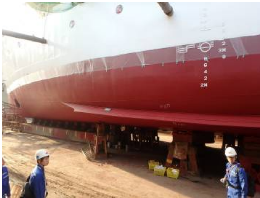
図28 「深江丸」の外板部(実証予備試験用塗料塗装前)
