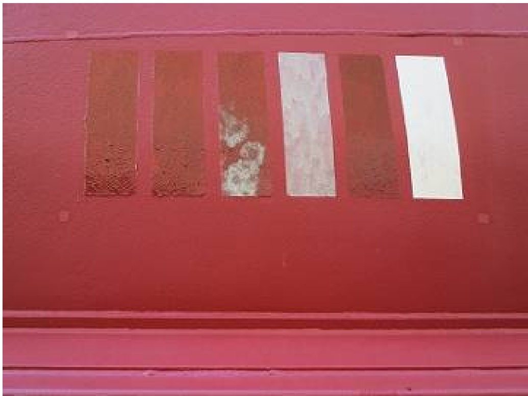
図 3 6 実証予備試験用塗料の乾燥 4 日後の状態（下部塗装箇所）
