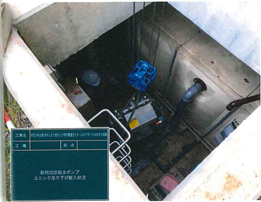
工事名 令和元年度国土計画により実施した特定河川整備事業（水門・ポンプ・貯水池）の整備 工程 測点 新規加圧給水ポンプ ユニック吊り下げ搬入状況
