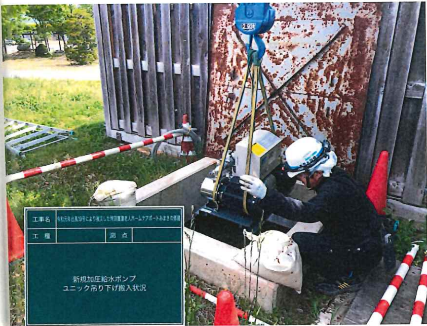
工事名 令和元年度国土計画により実施した特定河川整備事業（水門・ポンプ・貯水池）の整備 工程 測点 新規加圧給水ポンプ ユニック吊り下げ搬入状況
