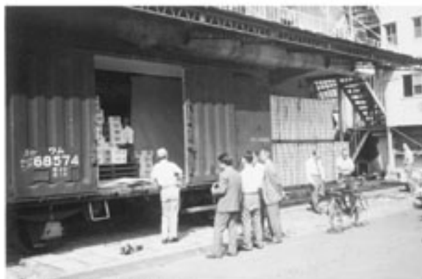
引込線の貨車に積込んだ缶詰
