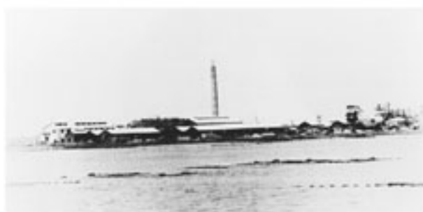
建設中の清水工場全景 昭和15年5月
