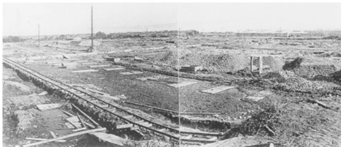
清水工場の基礎工事 昭和18年
