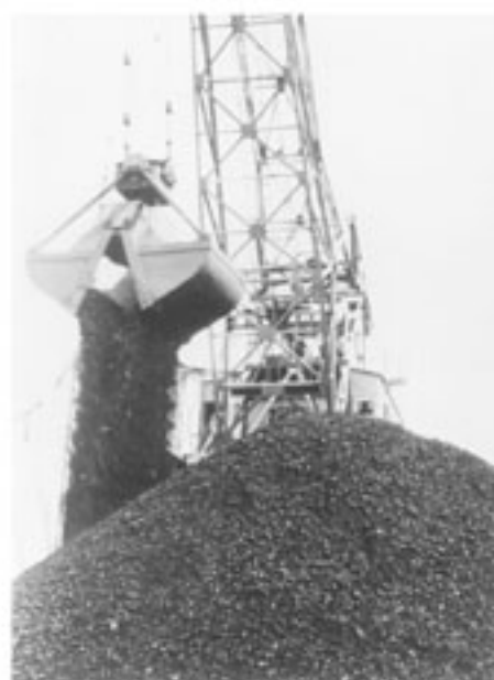
鉄道岸壁における省炭荷役 （5トン門型走行水平引込式ジブクレーン）
