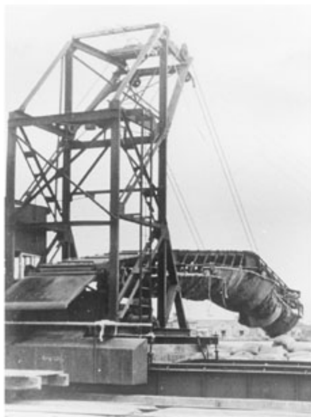
エプロンコンベヤー（豊年岸壁）
