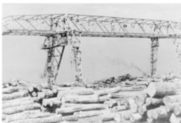
3トントランスポーター（大橋川木材置場）
