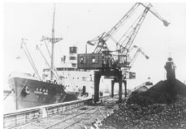
鉄道岸壁における省炭荷役（ジブクレーン1号機・2号機）
