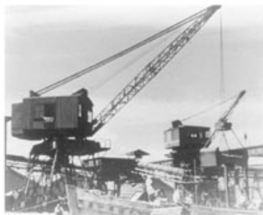
5トン門型走行式ジブクレーン(5号岸壁)
