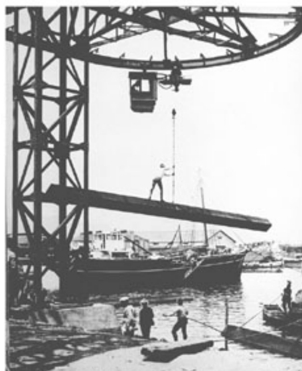
テルファーによる米材の積車積 (米材を水平に保つため作業員がバランスをとっている)
