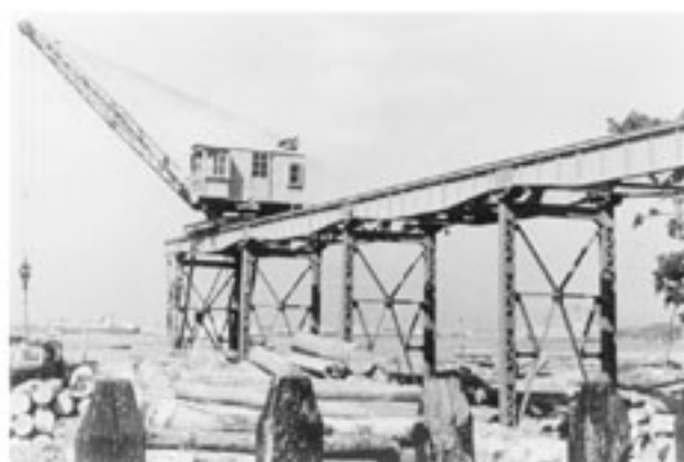
5トン高架走行式ジブクレーン（折戸野木場）
