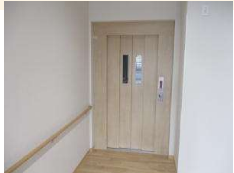
全館バリアフリー(専用エレベーター)
