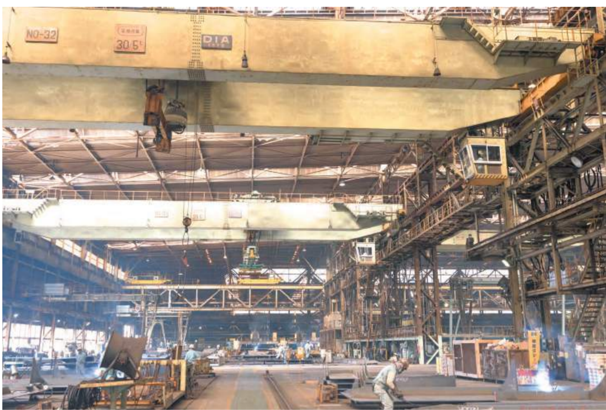
右上に見えるのが、木村さんが乗っているクレーン操縦室。工場全体を見渡しながら、細心の注意を払って巨大な鉄板などを吊り上げ、運んでいる。
