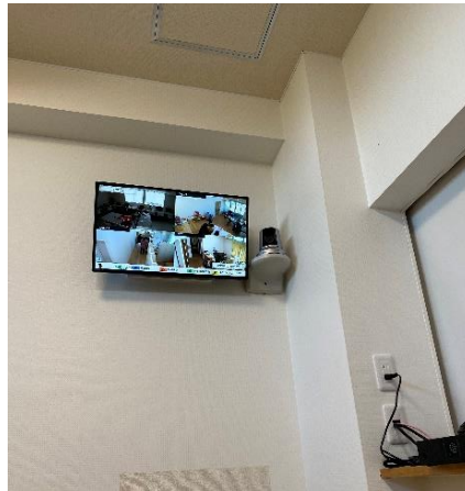
〈木津 1階 生活介護設置後〉
