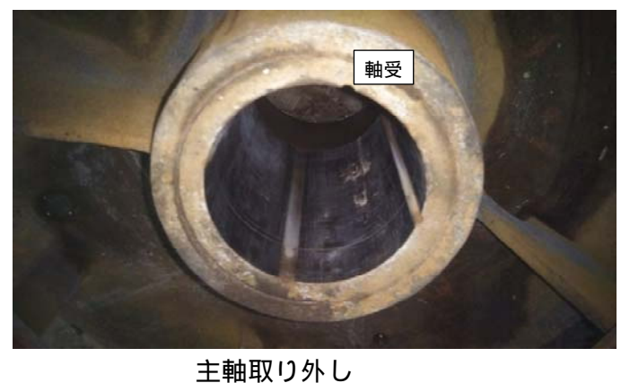
図 4.1.2 ポンプ開放状況 (ドック工事時)
