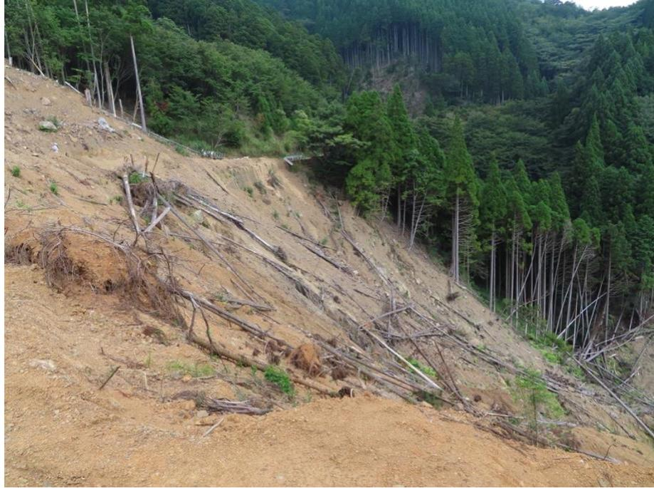
(曲がった尾根の内側に敷設された林道が大崩壊を起こした箇所。破碎帯に幅広林道敷設が原因。過去も何度も崩壊が発生している：2020年7月豪雨八代市坂本)
