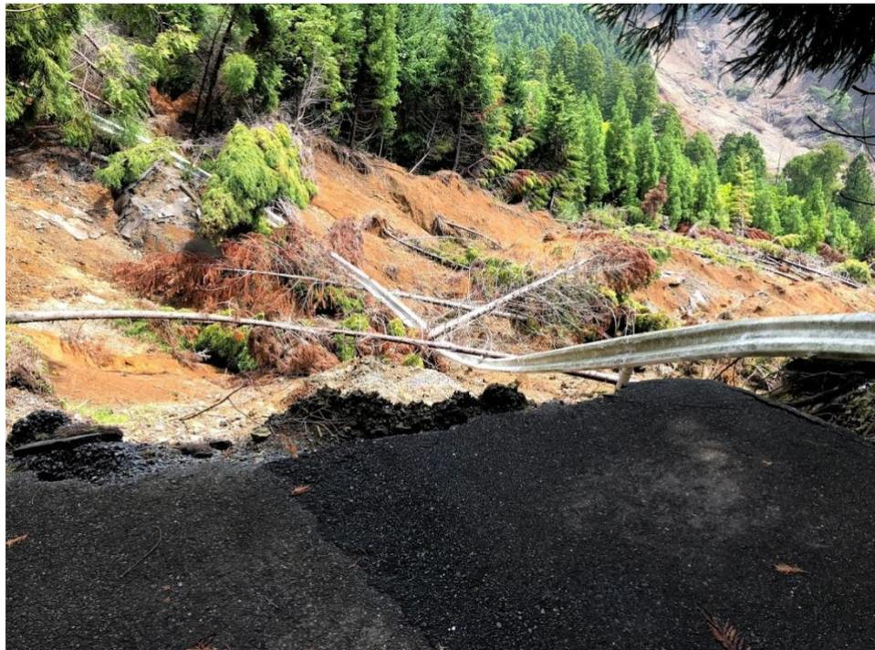
(林道の崩壊：横断排水の悪さと、谷渡りの悪さで谷水を乗せたことによる大崩壊：2017年九州北部豪雨災害：朝倉市)
