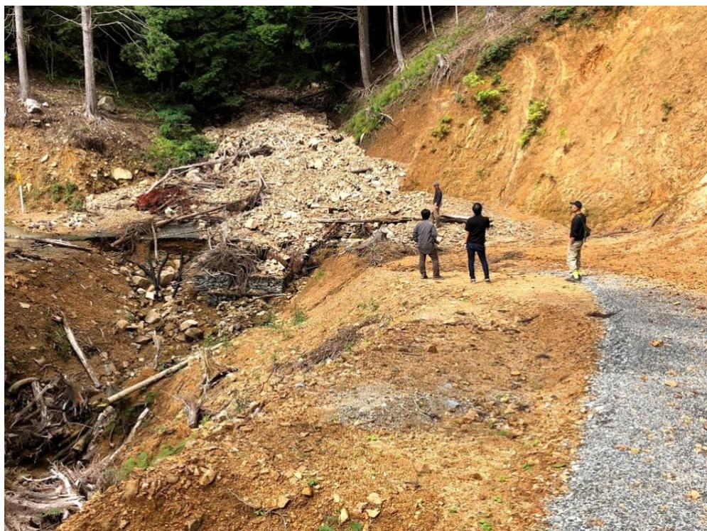
(支線作業道が崩壊による土石流が発生し、幹線作業道も崩壊した箇所：FSC 認
