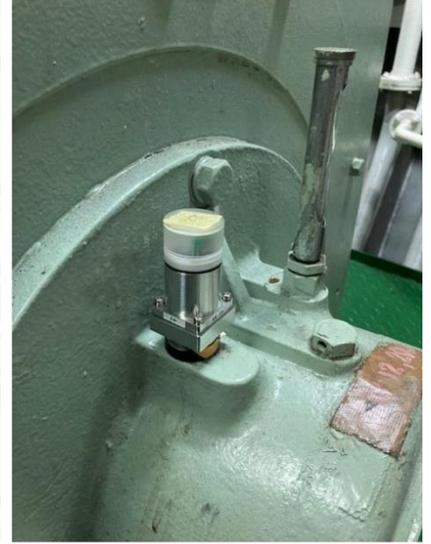
図 110 ②②No1 補機 Eng 発電機反直結側のセンサ設置場所
