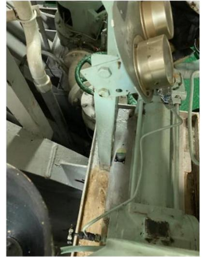
図 128 ②8FO 輸送ポンプ ポンプ側のセンサ設置場所
