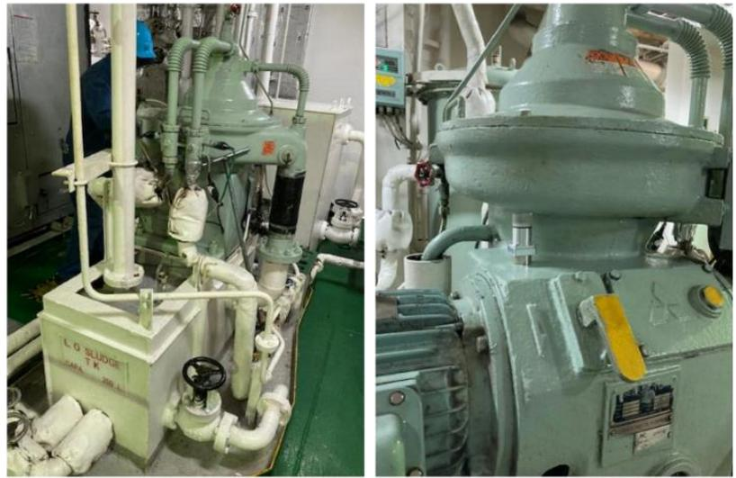
図 132 ②LOピューリファイヤーのセンサ設置場所
