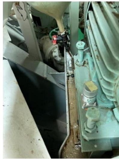
図 119 ②5FO 輸送ポンプ モータ側のセンサ設置場所
