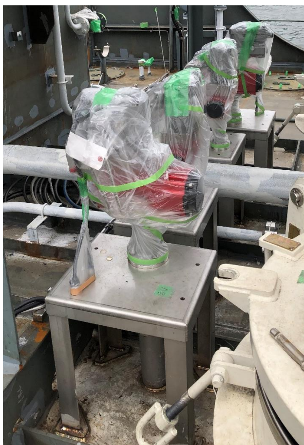
写真 17 ポジシヨナ取付架台
