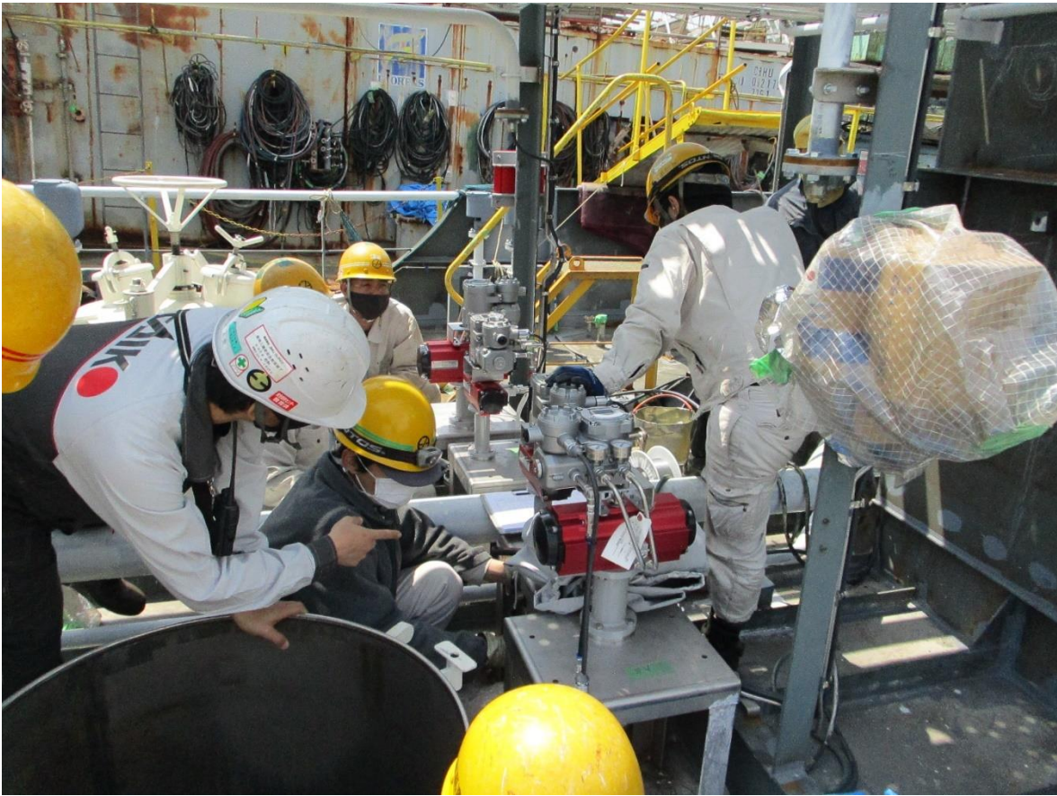
写真 18 ポジショナ取付・結線作業
