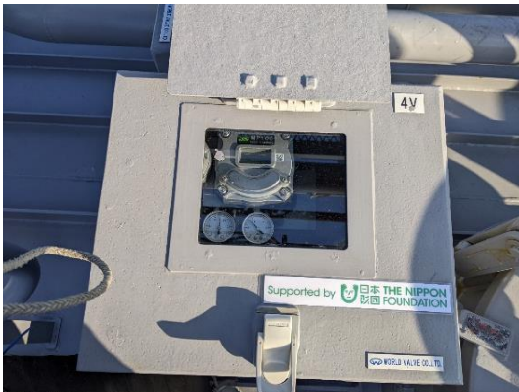
写真13 バルブカバー上部覗き穴
