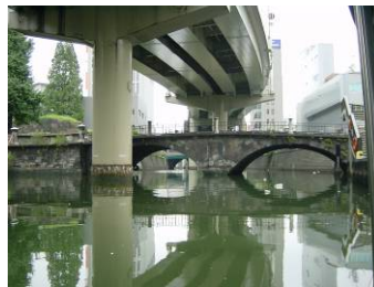
建造されて130年経つ常磐橋
