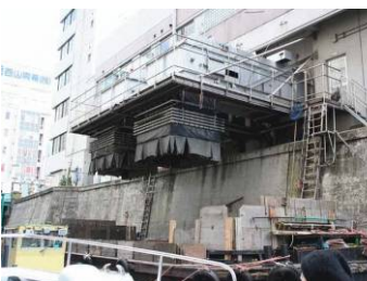
不燃ゴミを埋立地へ運ぶための積み込み施設
