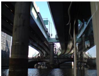
高速に覆われた日本橋
