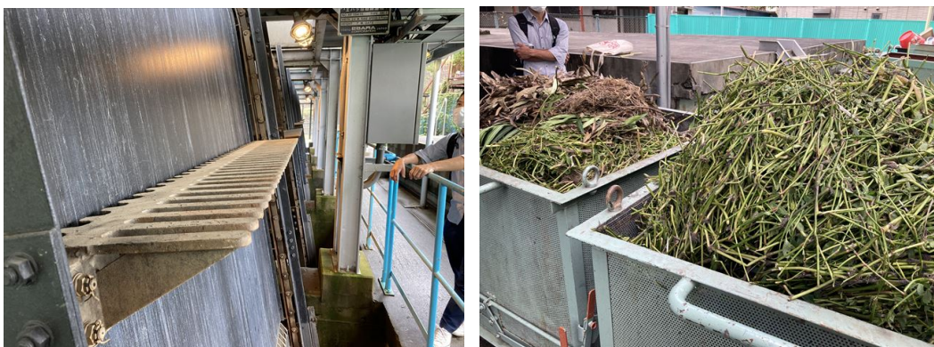
写真 2-2 (左) 排水からごみを回収する装置、(右) 回収された自然物と人工ごみ 画像：ACF 撮影（2020年10月13日撮影）
