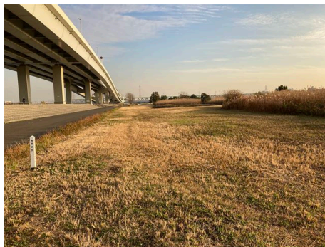
写真 6-24 刈払によって河川敷道路からの立入が可能になる（2021年12月16日撮影）
