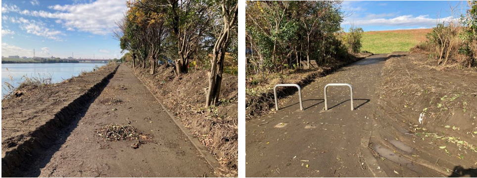
写真 6-21 露出された遊歩道と回復した見通し（2021 年 12 月 17 日撮影）
