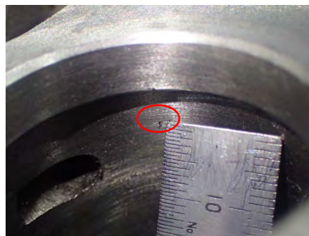
加工後の欠陥の状況
