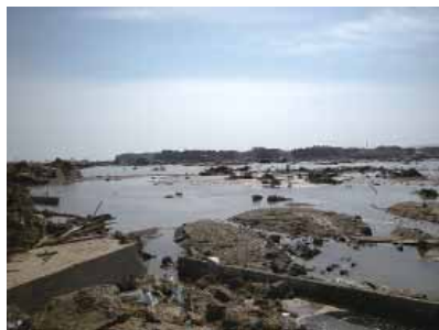
津波による被災状況（山元町）
