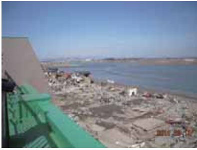
市街中心部から関上大橋(北西方)を望む
