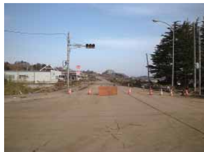
現場(亶理郡山元町)入口 玉川チーム
