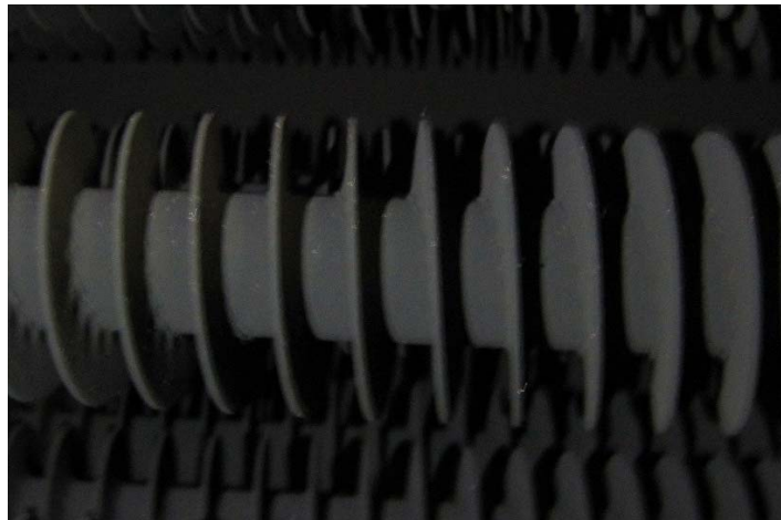
図 92 ブロー前の 6 段目のフィン付き伝熱管
