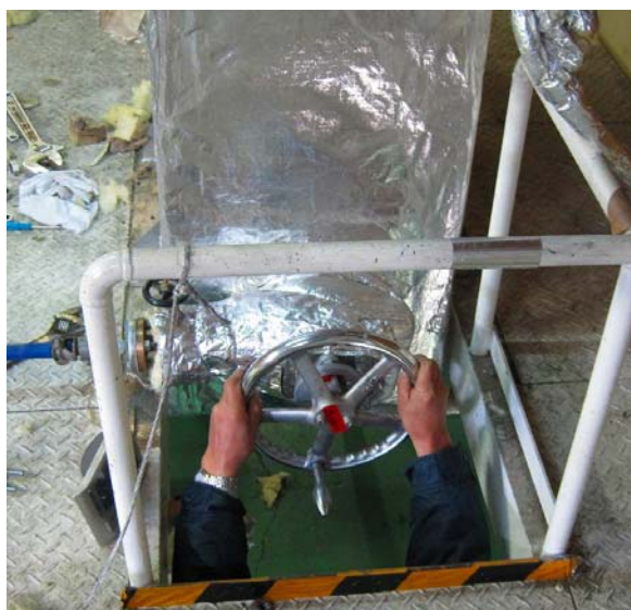
図 90 ハンドルを回し、ブロー方向をゆっくり変えている様子
