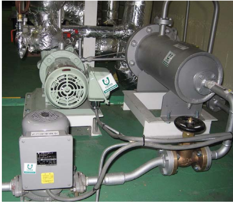
図 11 循環水ポンプと冷却系（復水器と冷却系ポンプ）の外観 左：中央がモーター、その奥が循環水ポンプ、下が冷却用ポンプ 右：水平円筒状が復水器
