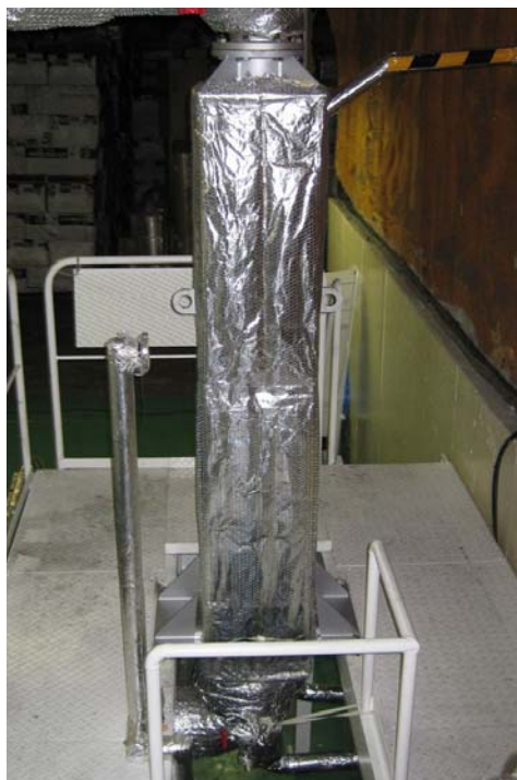
(B) 断熱施工後 ((A)と反対側から見る)
