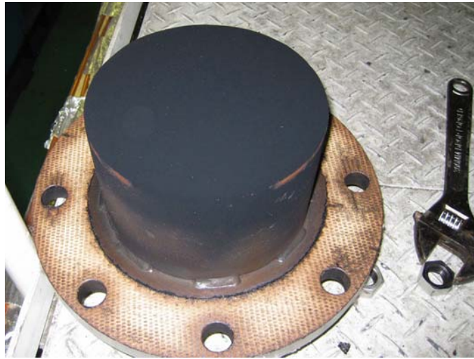
図 91 点検口の保温材（厚さ 200mm）に付いたスス
