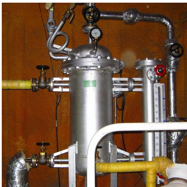
図 62 水圧試験中の汽水分離器と循環ループ （保温材が外された黄色の部分）
