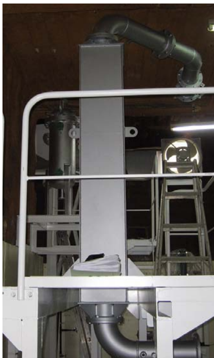
(A) 断熱施工前 (奥に、換気ファンが見える)
