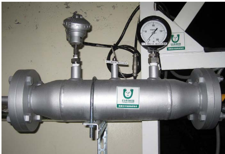
図 19 センサー取り付け状況例（左から、F4、P5、T8）
