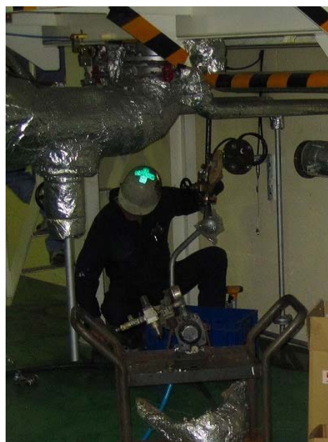
図 63 水圧負荷操作の様子
