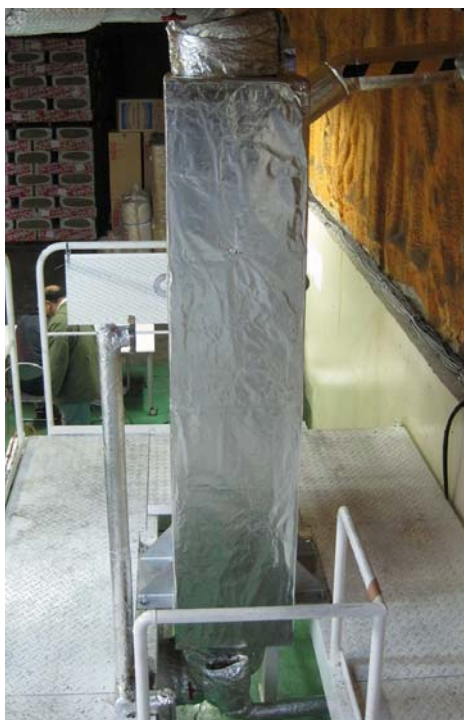
図 26 補強後の標準サイレンサ
