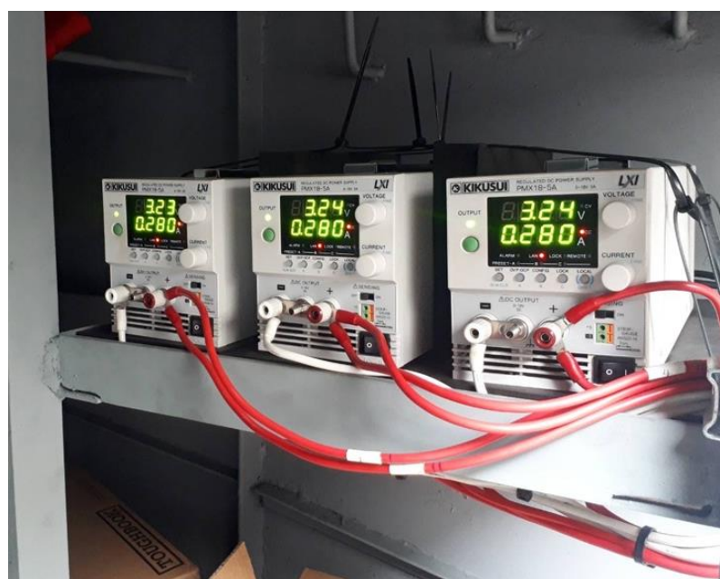
図 4 9 通電用直流安定化電源設置の様子
