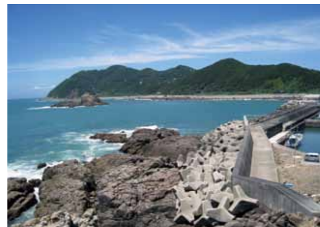
取材当日の事故発生現場。ここまで登るのも一苦労する状況で、担架の使用は確かに不可能
