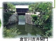
倉安川吉井閘門
