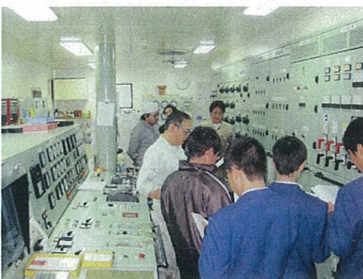
機関部乗組員から機関制御盤の操作方法を学ぶ
