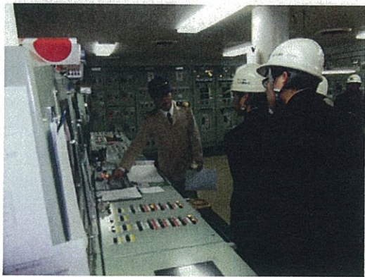
機関部乗組員から機関制御盤の操作方法を学ぶ
