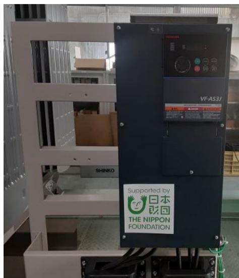
写真46. ポンプ付属機器インバータ
