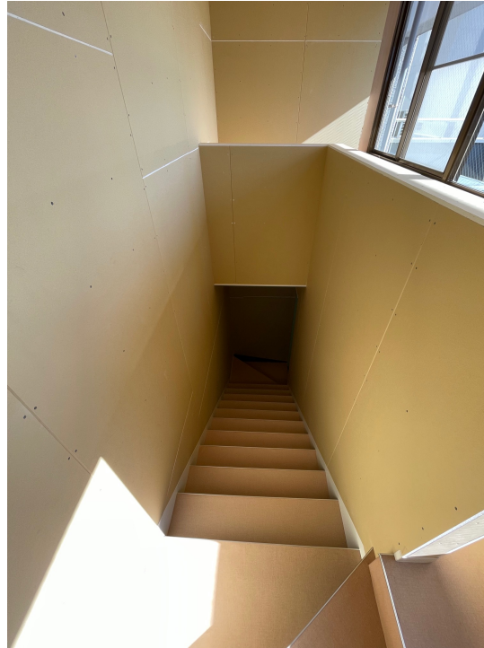
屋上側から見た事務所への階段
