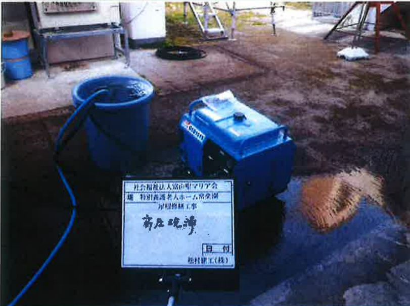
撮影項目 高圧洗浄
