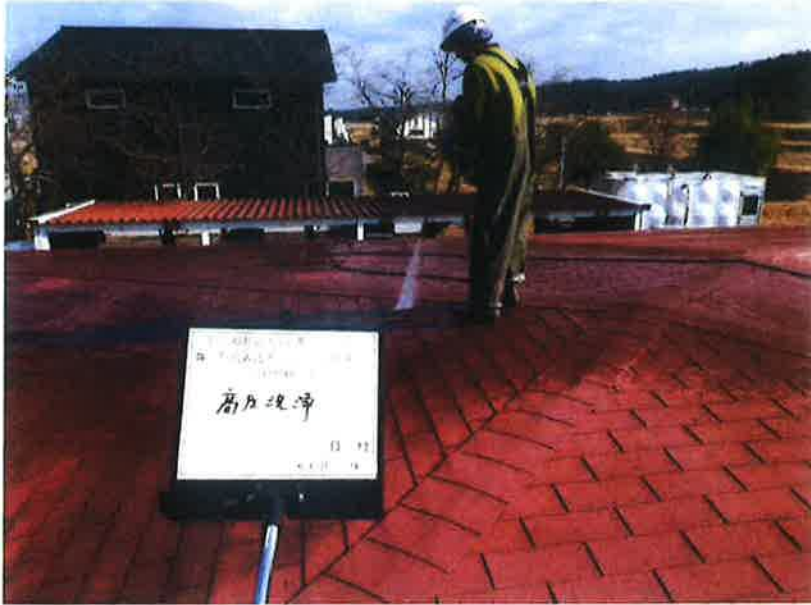
撮影項目 高圧洗浄
