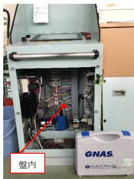
図 3-17 バラスト制御装置盤内
