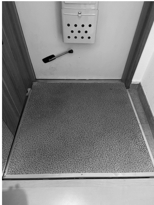
【写真】 玄関の段差を埋めるためのスロープ
