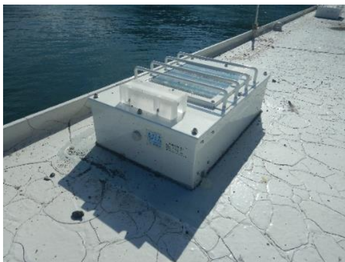
図-51 撤去前外観
