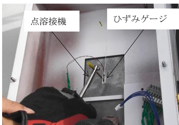
図-59 ひずみゲージ溶接状態
