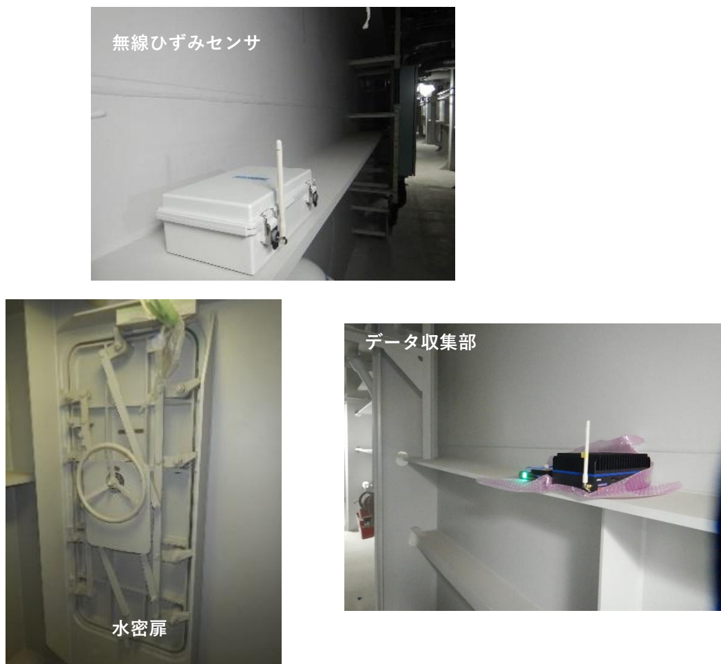
図-71 機器設置状態
