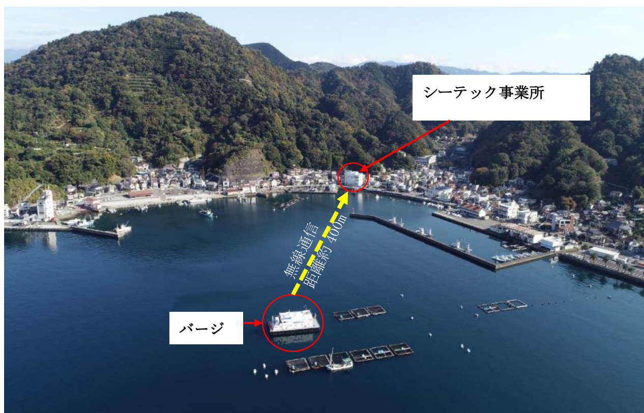
図-32 バージ洋上配置（静岡県沼津市三津 内浦湾）
