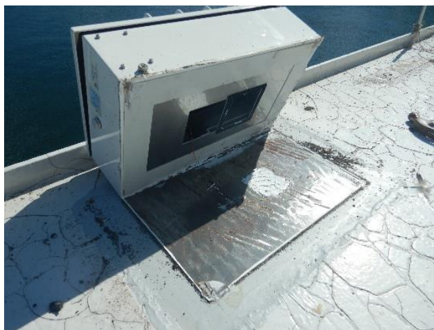
図-54 筐体撤去後の状態
