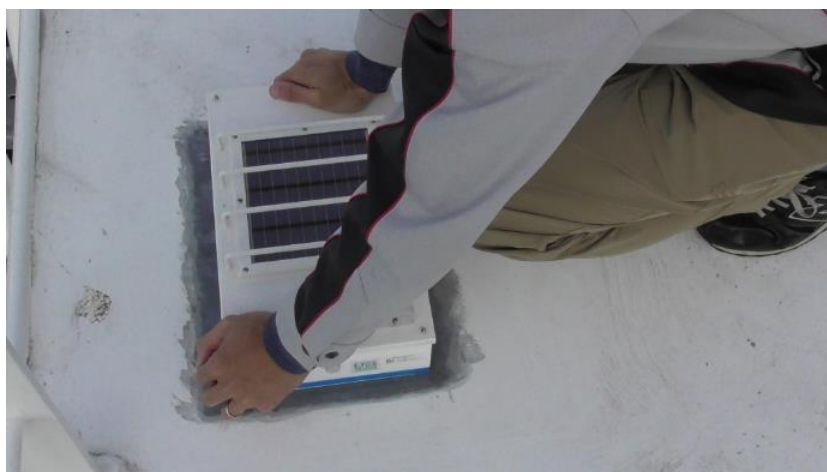
図-58 甲板への貼り付け状態
