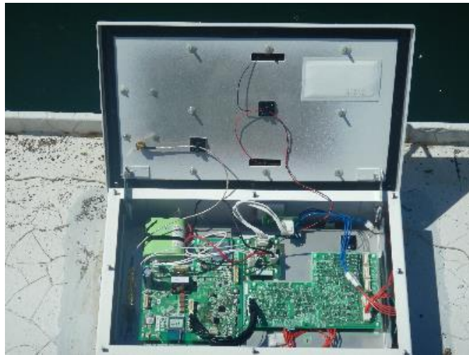
図-44 基板設置、配線完了
