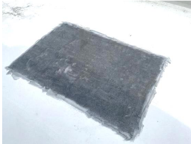
図-56 塗装除去、#100仕上げ後
