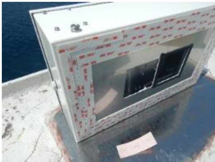
図-39 筐体への VHB テープ貼り付け状態
