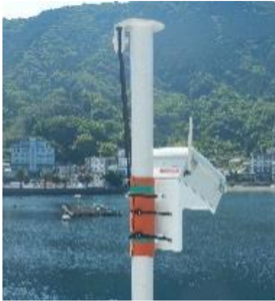
図-46 設置完了状態
