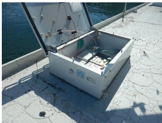
図-53 基板撤去後の内部状態
