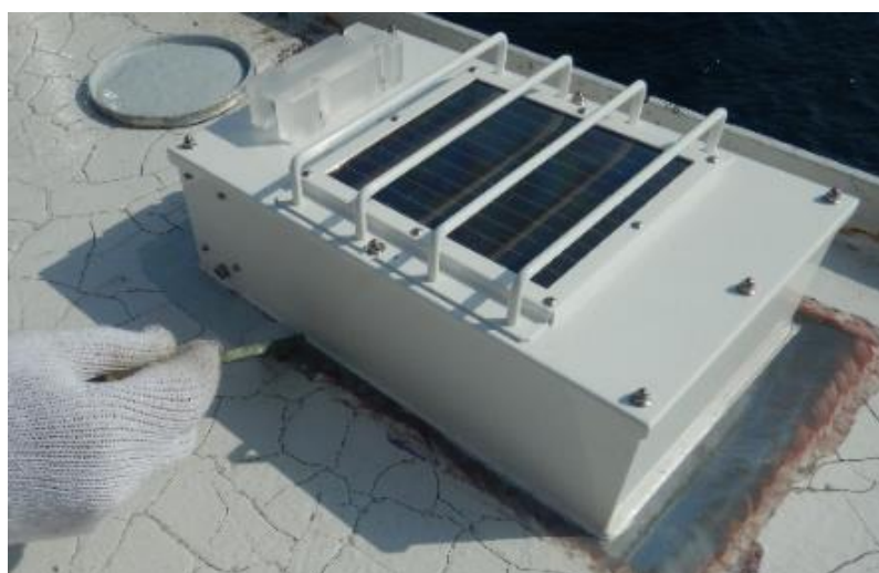
図-43 再塗装作業
