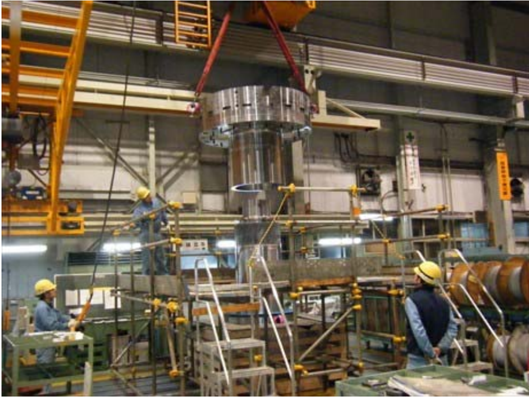
写真65 クラッチキャリア～クラッチリングを出力軸へ組み込み①
