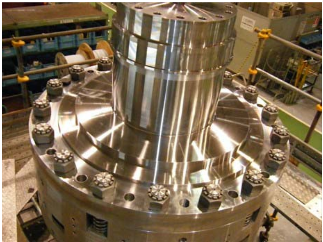
写真 7 2 クラッチボルト締付完了姿
