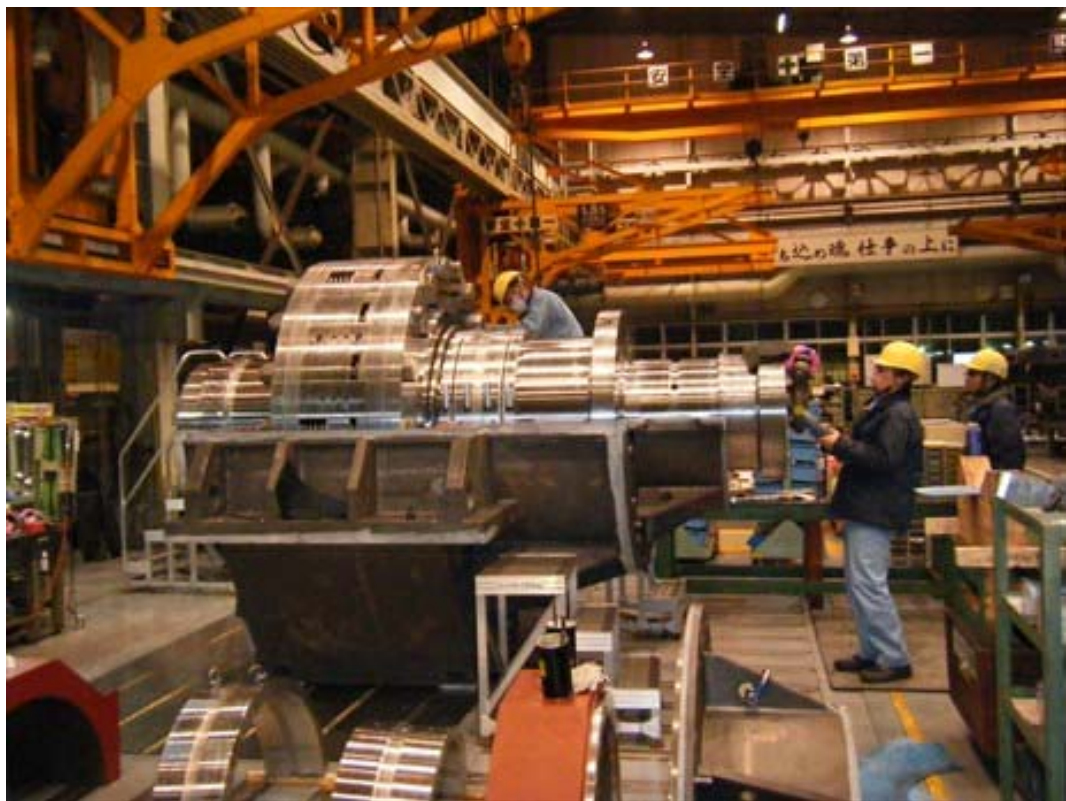
写真 7 6 内部回転体の下ケーシング (HSG-2) への組み込み完了
