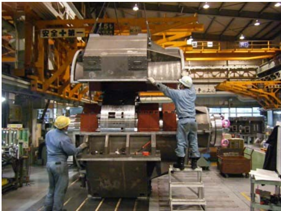
写真80 上ケーシング (HSG-1) 組立途中
