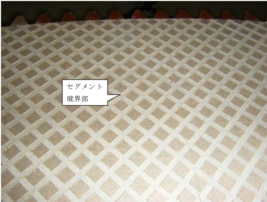
写真 3 4 溝加工後（境界部）
