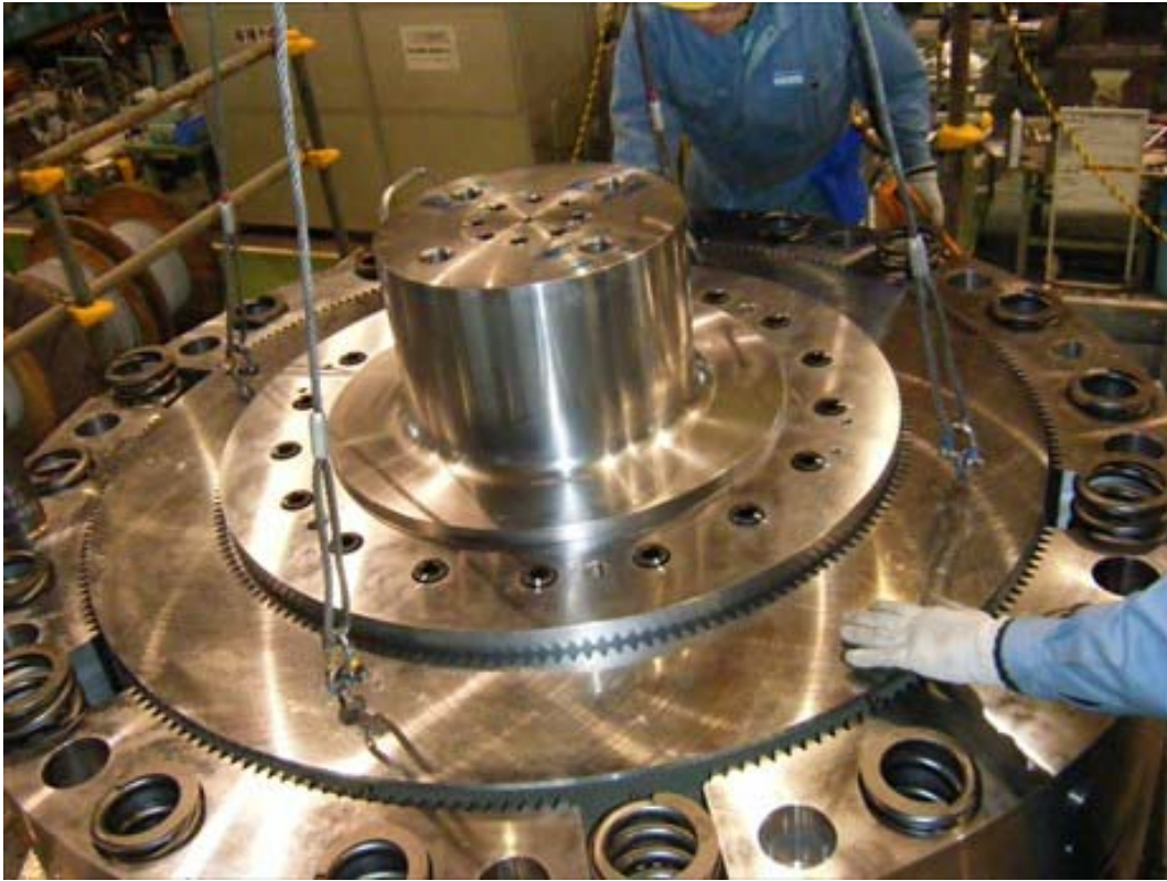
写真 6 9 クラッチプレート（スチールプレート）組み込み
