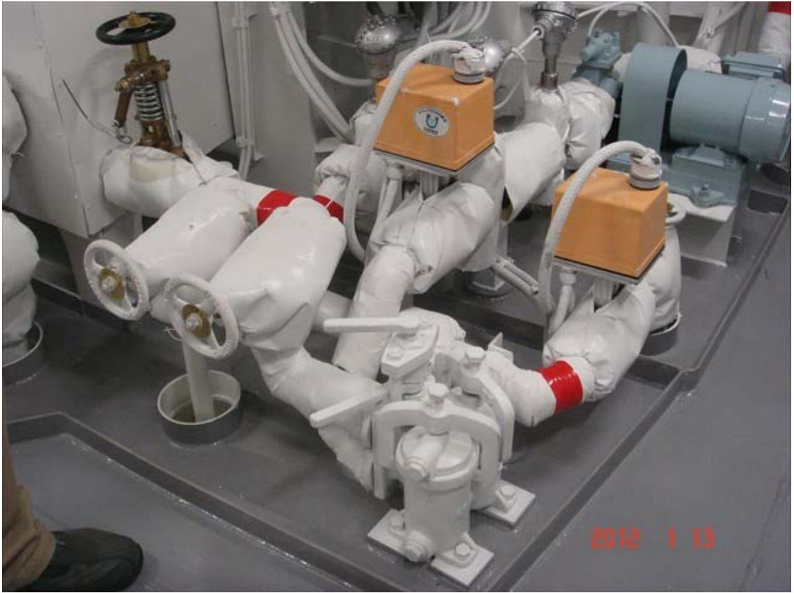
写真 5.55 燃料油混合装置搭載時
