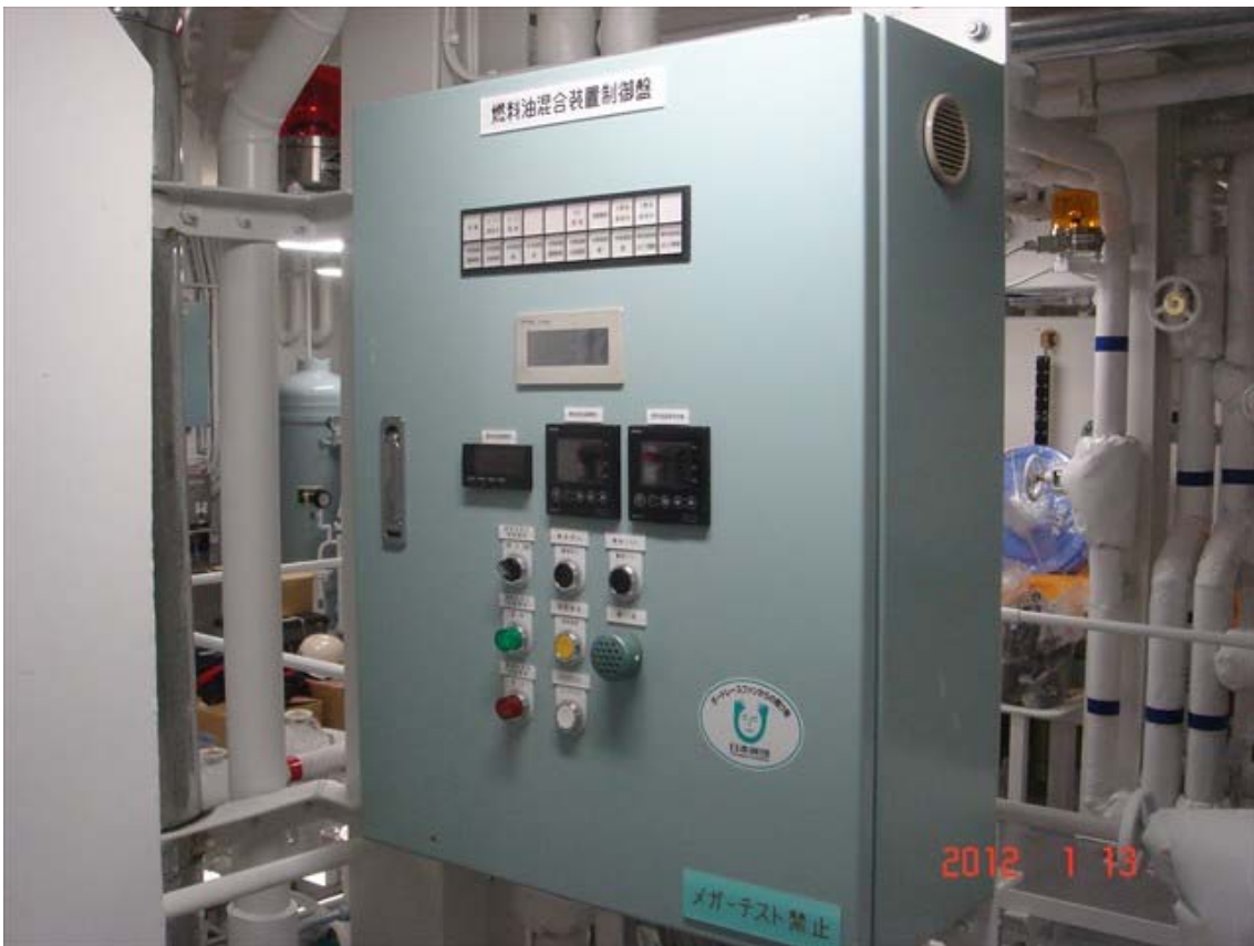
写真 5.54 燃料油混合装置制御盤搭載時
