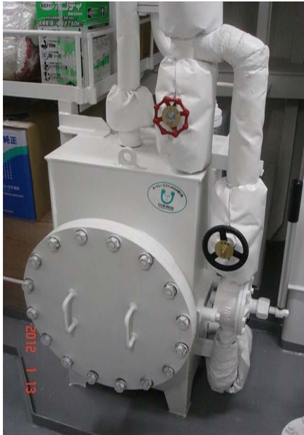
写真 5.51 熱媒油貯タンク搭載時
