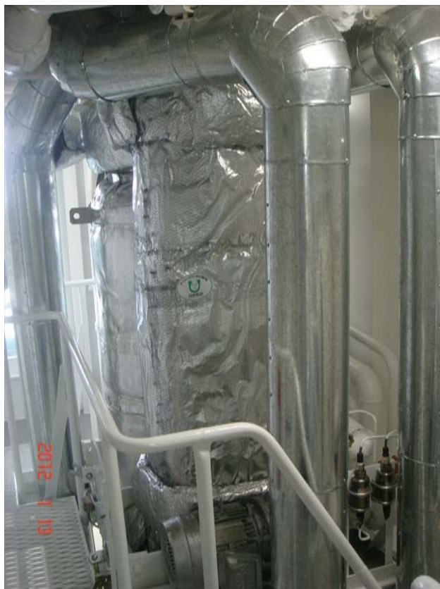
写真 5.52 排ガス熱交換器搭載時
