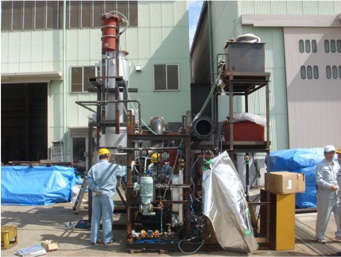
写真 4.43 陸上での性能確認試験準備
