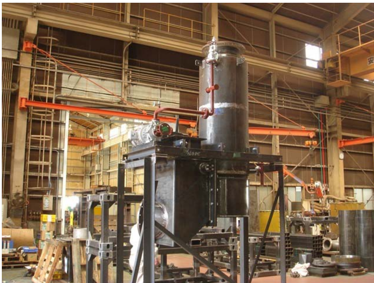
写真 3. 42 排ガス熱交換器本体組立作業
