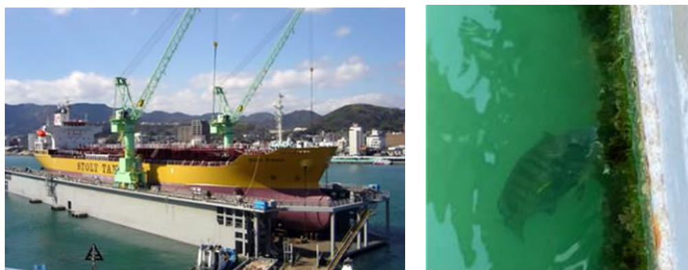
図 5-16 浮きドック外観と側面の生物付着の状況
