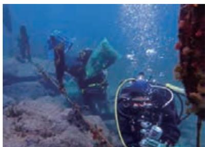
夏から秋にかけてウニの駆除・移植をおこない、適正な密度にウニを減らした段階で、U字ボルトの設置作業をおこないます。岩場に水中ボンドでU字ボルトを固定します。
