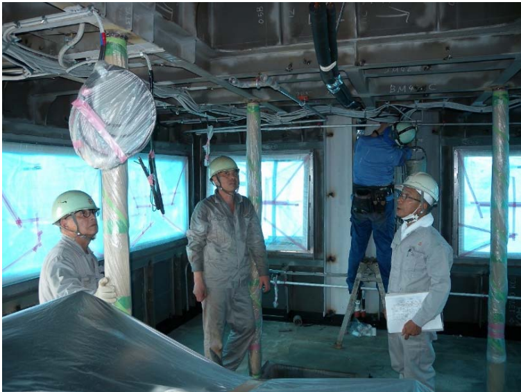
艙装工事（電路敷設）
