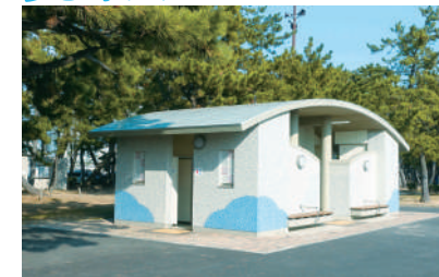
多目的トイレ
