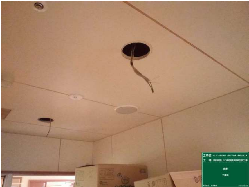
1階病室LED照明器具等 取替工事
