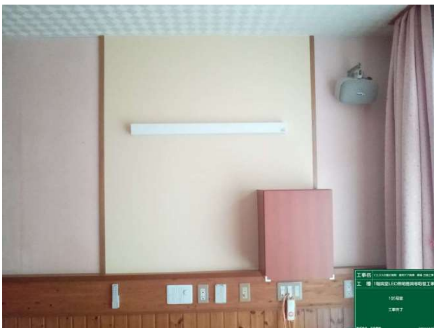
1階病室LED照明器具等 取替工事
