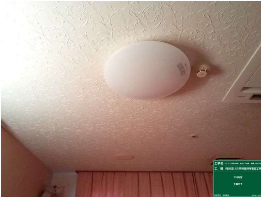
1階病室LED照明器具等 取替工事
