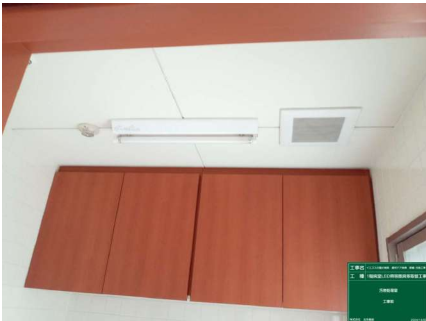
1階病室LED照明器具等 取替工事
