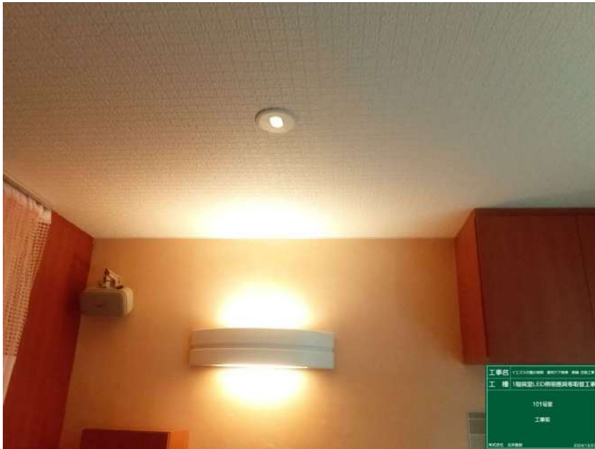
1階病室LED照明器具等 取替工事
