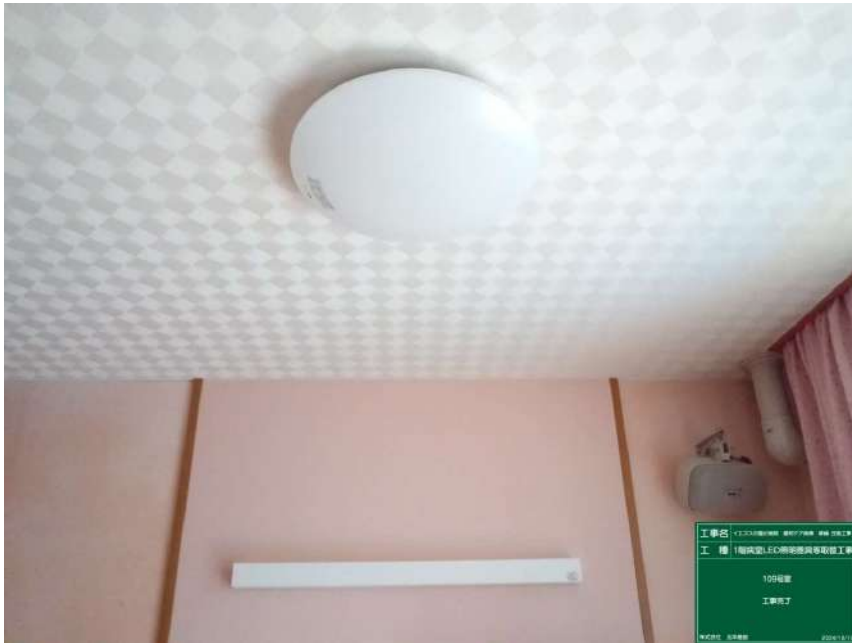
1階病室LED照明器具等 取替工事
