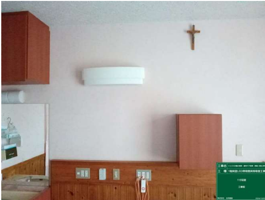
1階病室LED照明器具等 取替工事
