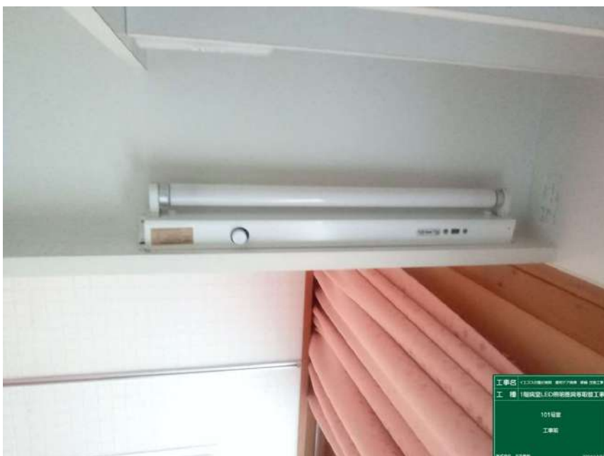
1階病室LED照明器具等 取替工事
