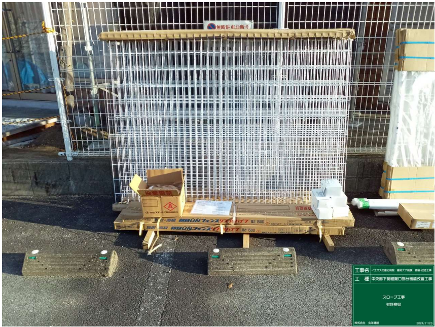
中央廊下側避難口部分 改修工事
