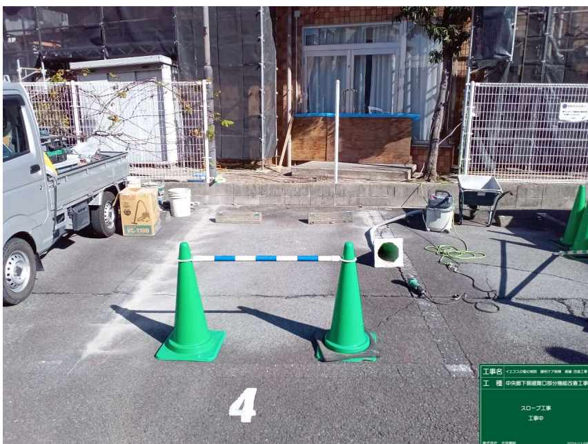
中央廊下側避難口部分 改修工事
