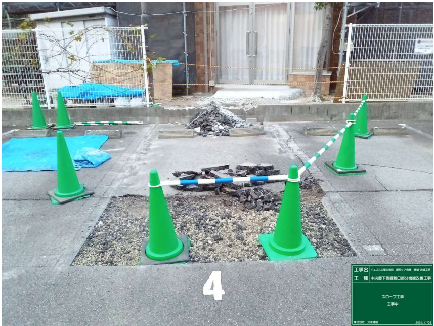
中央廊下側避難口部分 改修工事
