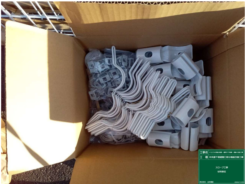
中央廊下側避難口部分 改修工事
