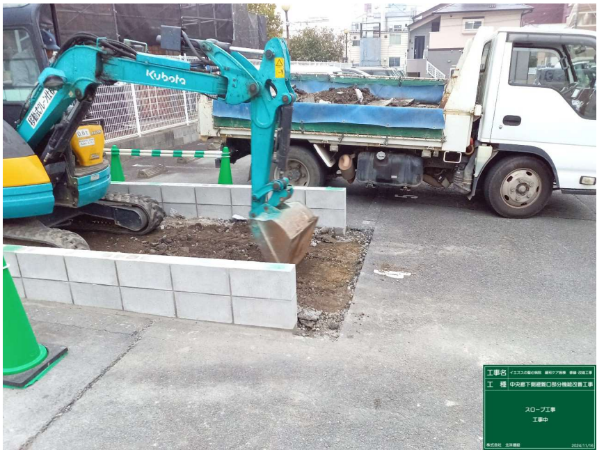
中央廊下側避難口部分 改修工事
