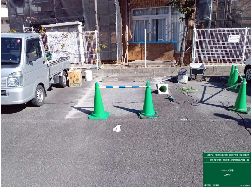
中央廊下側避難口部分 改修工事
