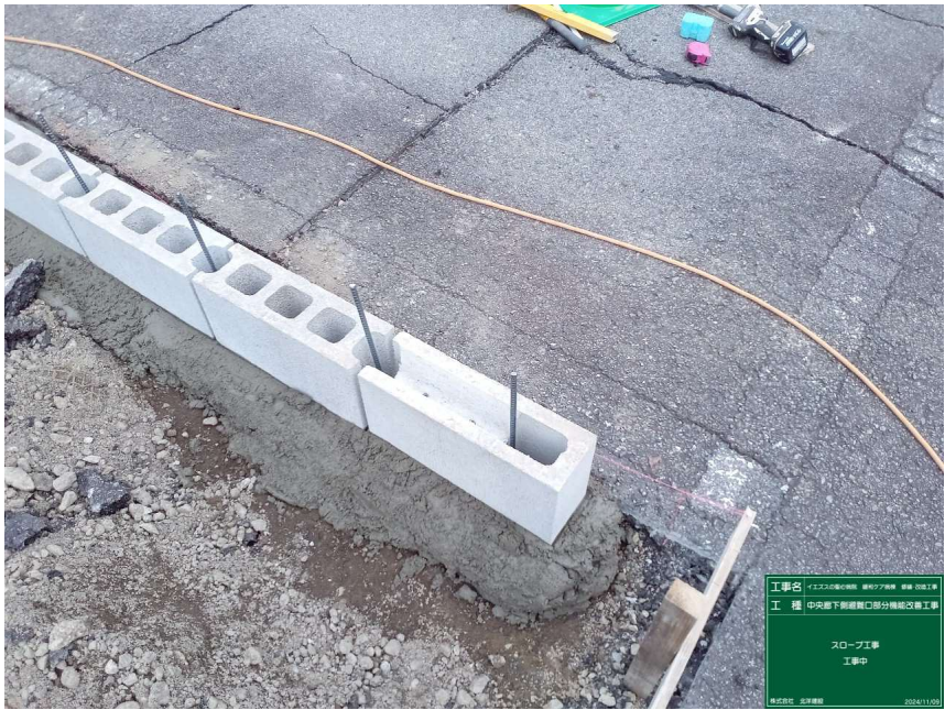
中央廊下側避難口部分 改修工事
