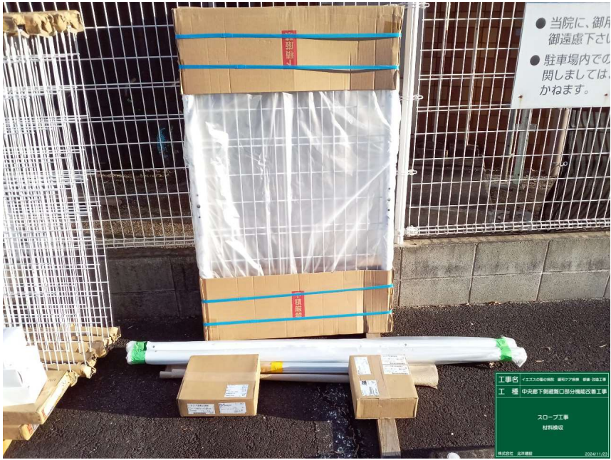
中央廊下側避難口部分 改修工事
