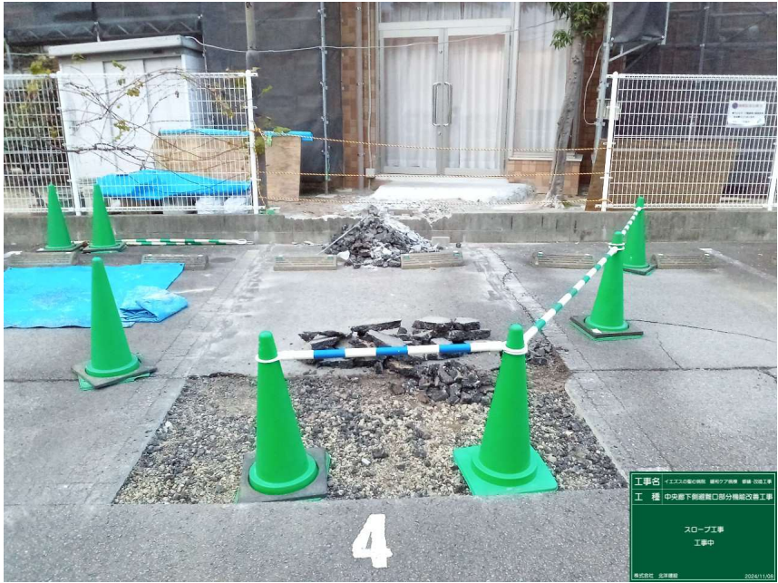
中央廊下側避難口部分 改修工事
