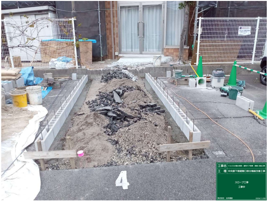
中央廊下側避難口部分 改修工事
