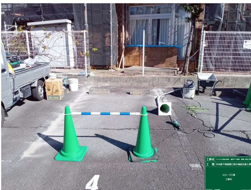
中央廊下側避難口部分 改修工事
