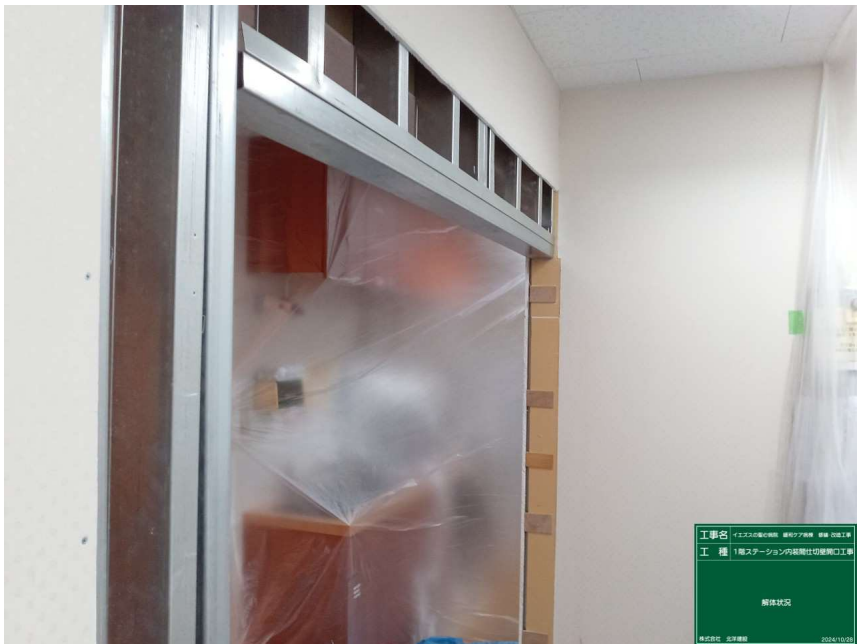
1階ステーション内 間仕切壁開口工事
