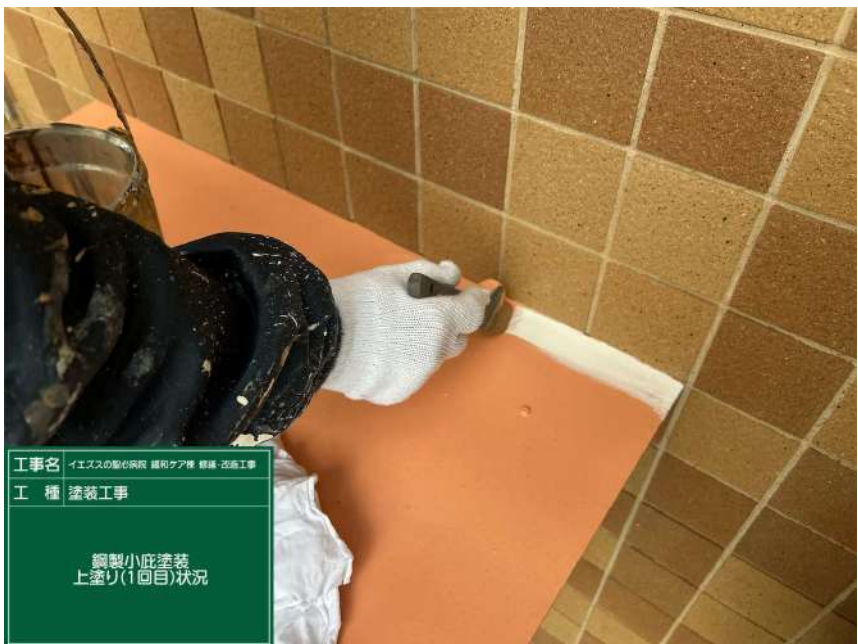
工事名 イエススの聖心病院 緩和ケア棟 修繕・改修工事 工 種 塗装工事 鋼製小底塗装 錆止め状況
