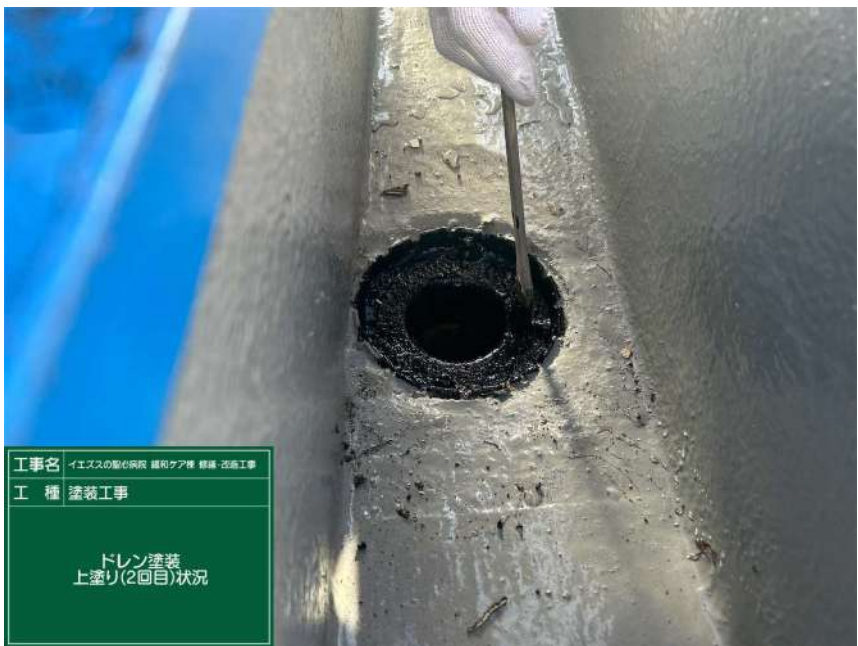
工事名 イエススの聖心病院 緩和ケア棟 修繕・改修工事 工 種 塗装工事 ドレン塗装 上塗り(1回目)状況
