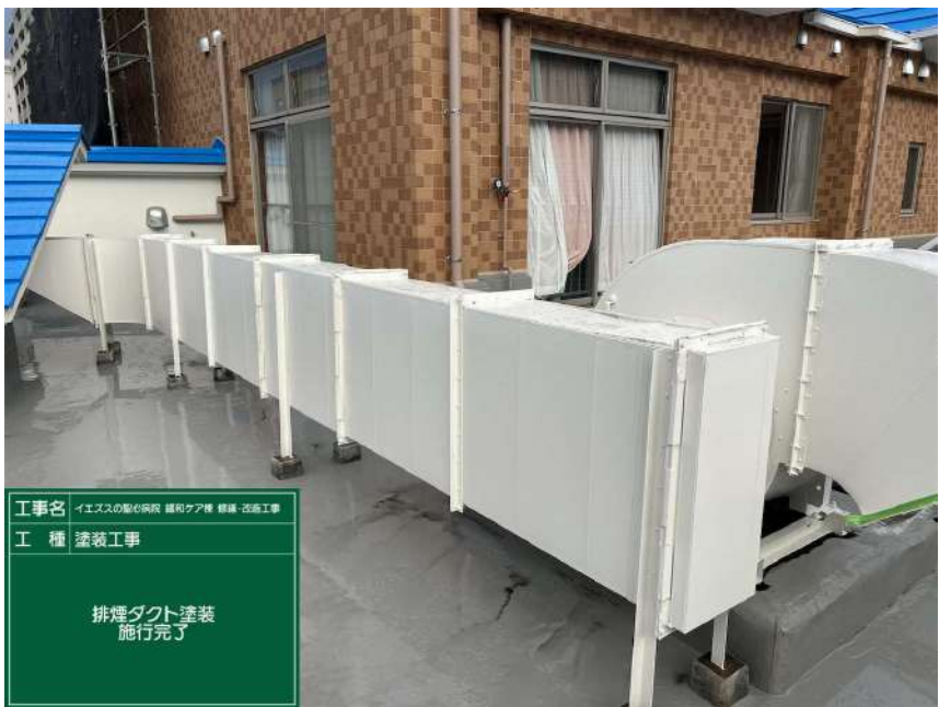
工事名 イエススの聖心病院 緩和ケア棟 修繕・改修工事 工 種 塗装工事 排煙ダクト塗装 上塗り(2回目)状況
