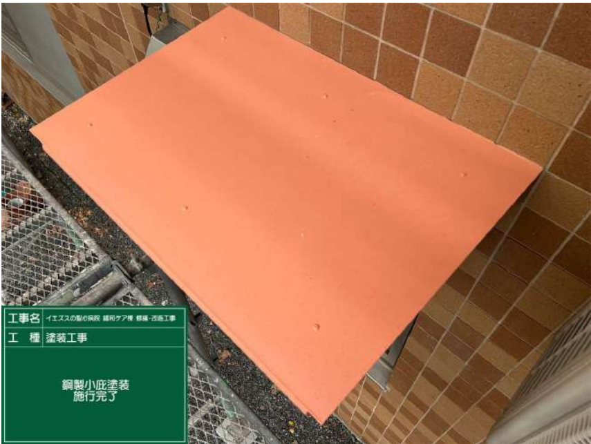
工事名 イエススの聖心病院 緩和ケア棟 修繕・改修工事 工 種 塗装工事 鋼製小庇塗装 上塗り(2回目)状況
