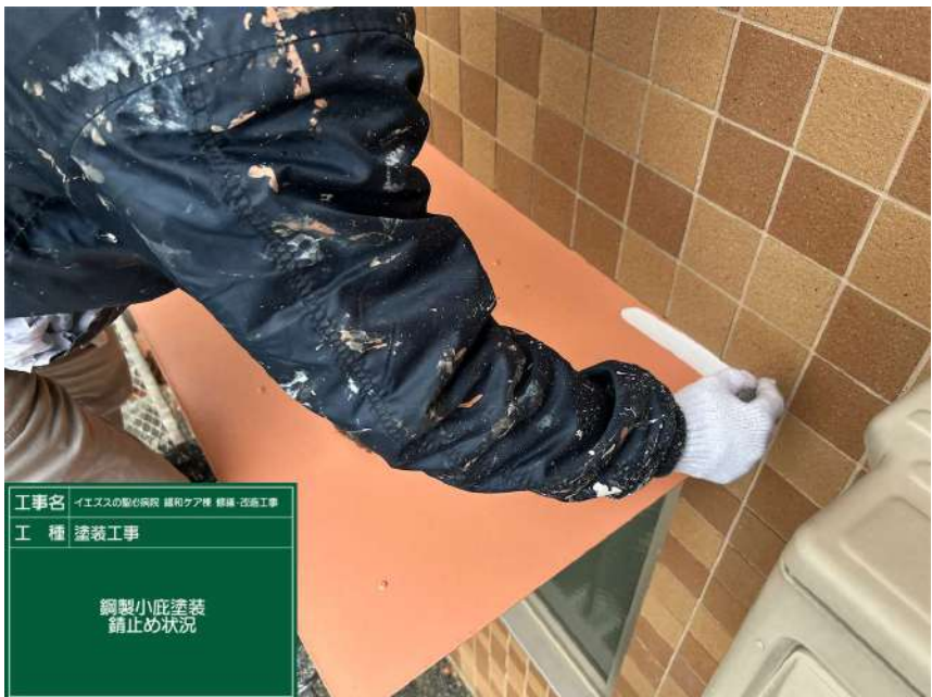
工事名 イエススの聖心病院 緩和ケア棟 修繕・改修工事 工 種 塗装工事 鋼製小底塗装 ケレン状況
