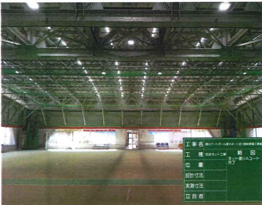
屋内ゲートボール場すばーく名川施設修繕工事業務
