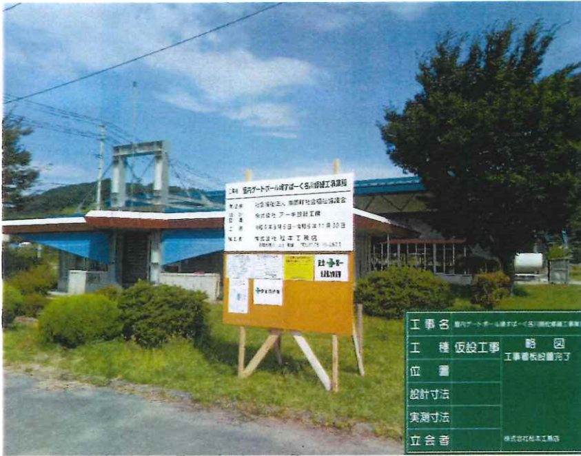
屋内ゲートボール場すばーく名川修繕工事
