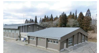
山田町B&G海洋センター 外壁
