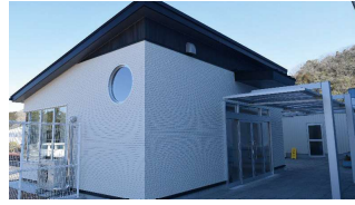
赤磐市吉井B&G海洋センター 多目的ホールの新設
