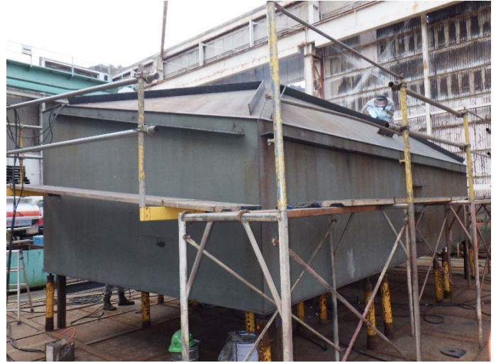
写真 3.2 船尾改造ブロック
