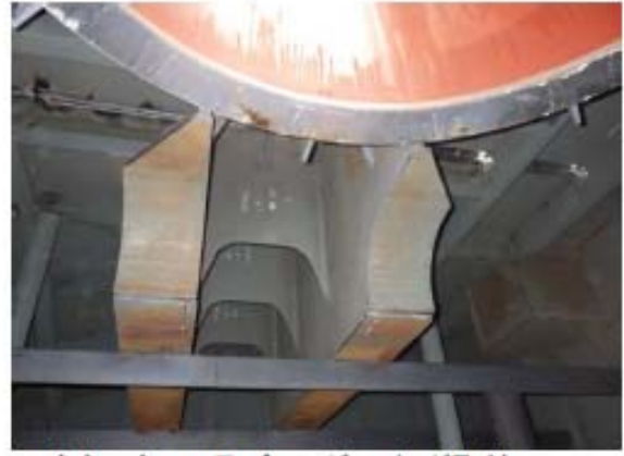
アウターウェル及びエンジンベッド取付
