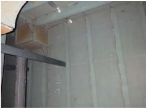
船底弁箱取付
