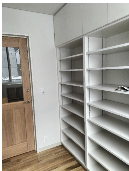
玄関下駄箱 取付
