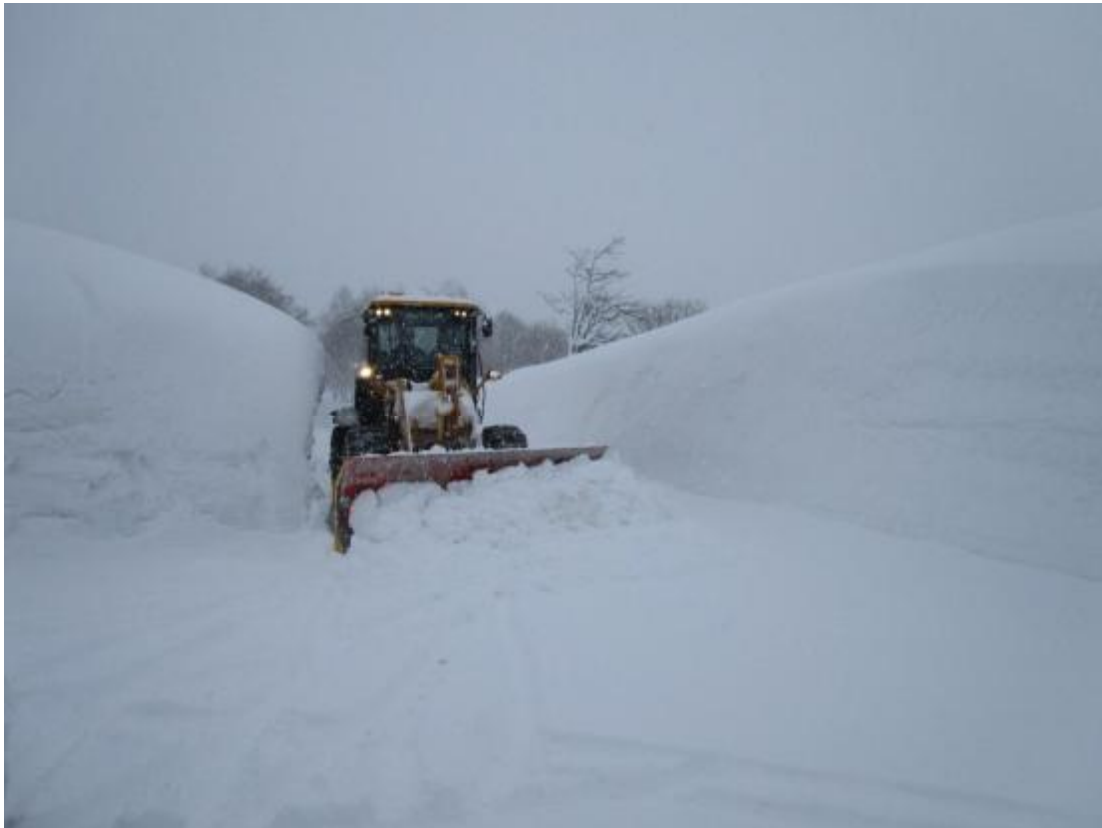
図表 付ー２ ドーザでの除雪作業
