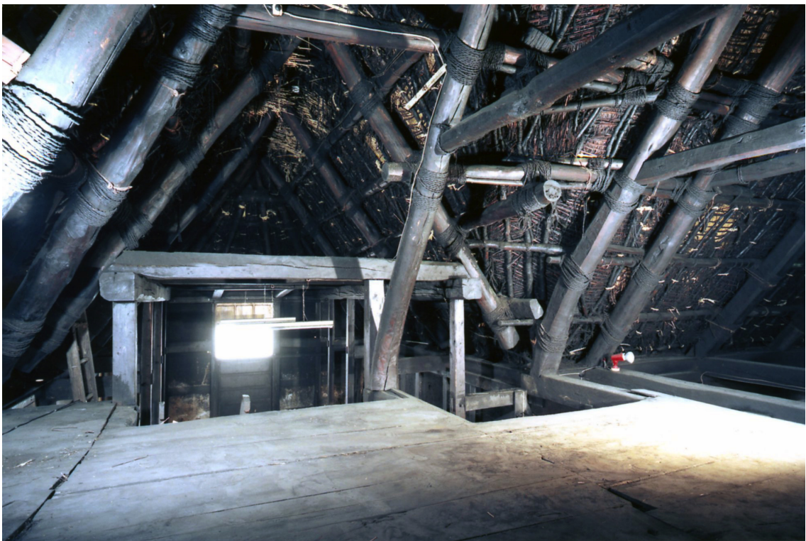
主屋 小屋裏 北西より*
