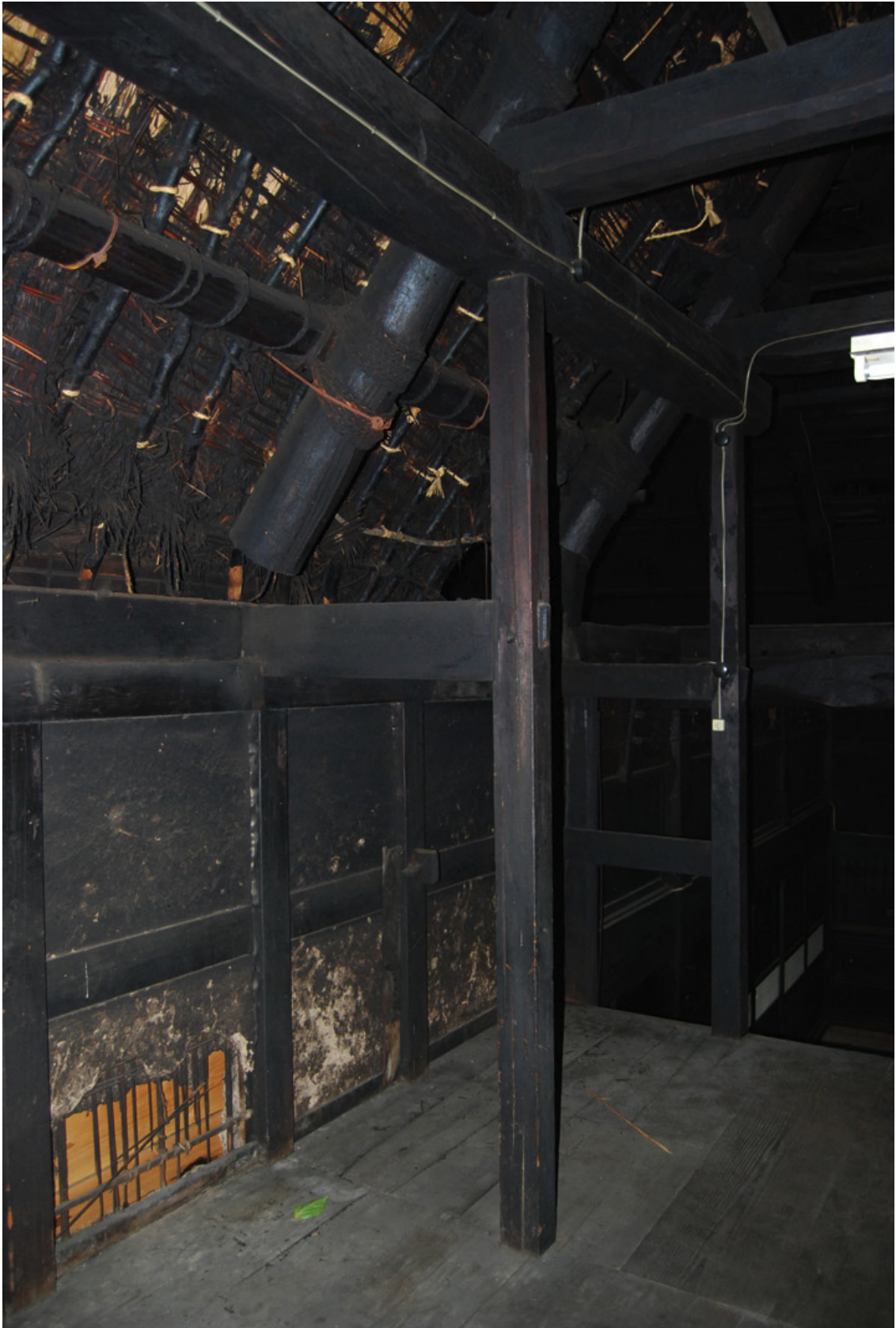
主屋 前中門小屋裏 北東より
