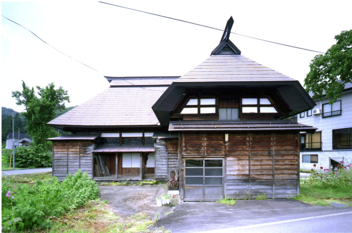
主屋 外観 東より*
