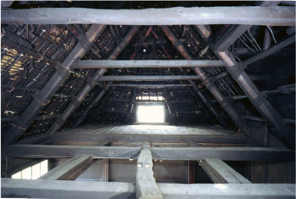
主屋 小屋裏 北より*
