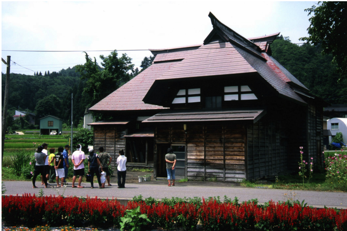
主屋 外観 東より*
