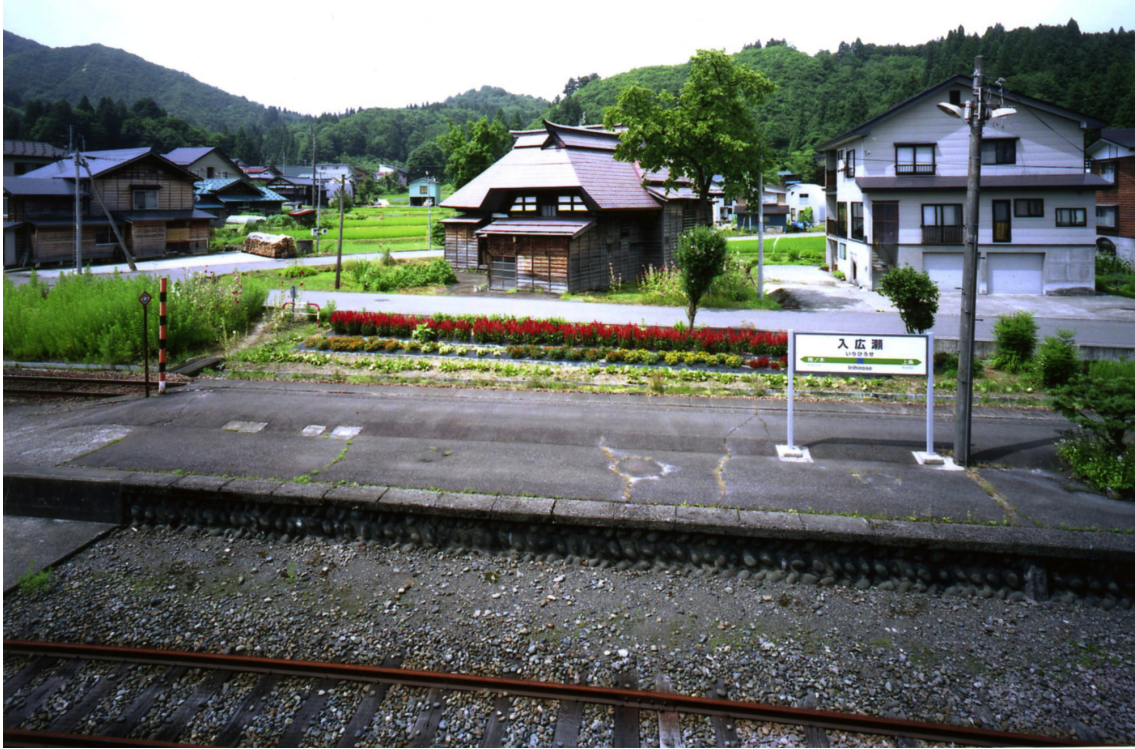
主屋 外観 東より*
