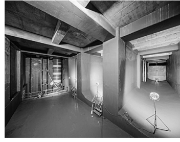
渋谷駅東口雨水貯留施設の概要 供用開始：2020年8月31日深さ：地下25m 最大貯留量：約4000ト (25m×6コースプール13個分相当)
