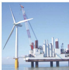
風車の据付工事、 SEP船等の作業船の新造
